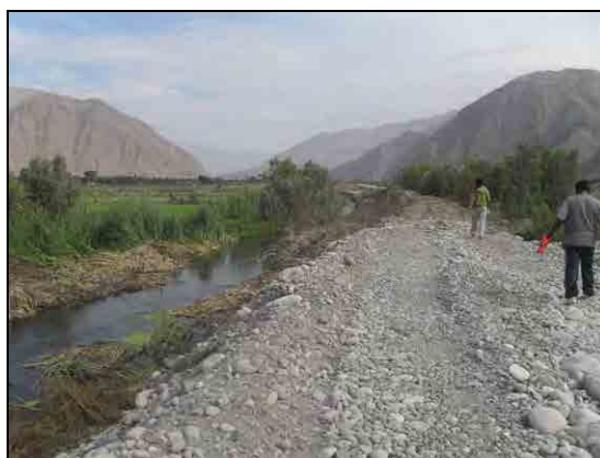
写真-4.2-3 PAMPA BLANCA 水路施設 (MC-05)
