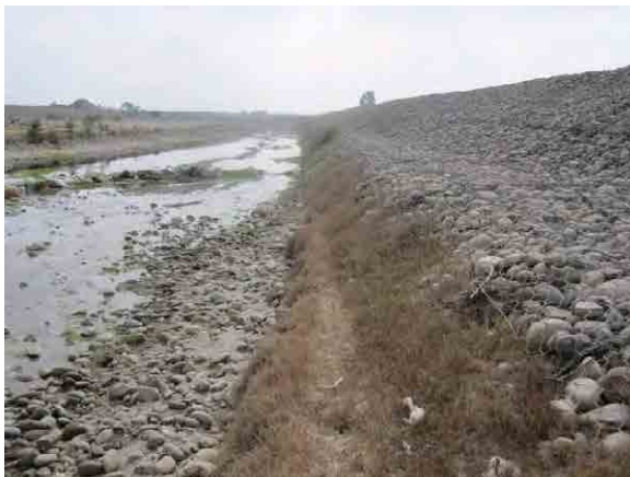
図 3-2 Chíncha 川の堤防 ふとん籠による護岸
