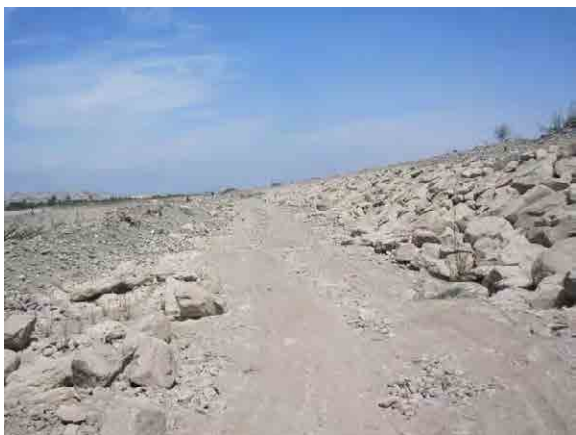
図 3.3 Pisco 川河口部の巨石護岸
