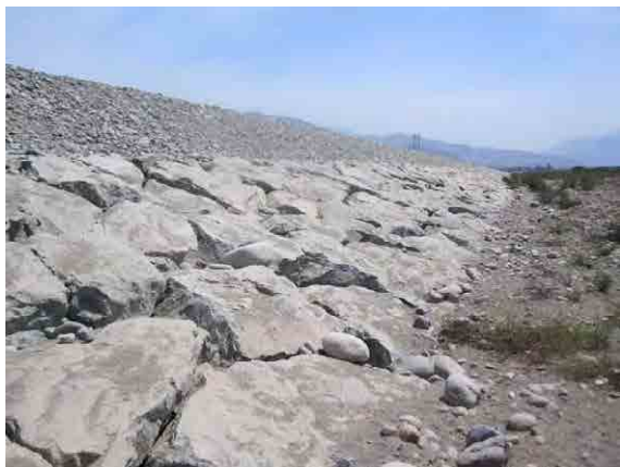
図 3.4 Pisco 川 上流部の堤防と巨石護岸
