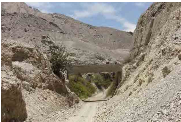
図-3.1.8-14 サンフランシスコ川の土砂堆積状況（灌漑水路が土石流により被災した。道路側壁はその時の土石流堆積物）
