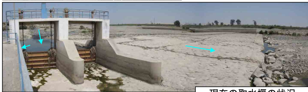
現在の取水堰の状況
