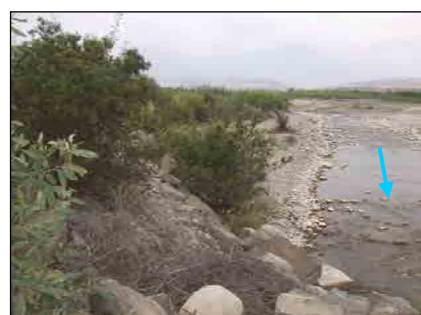
再構築された堤防の状況
