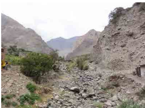
図-3.1.8-8 安山岩質～玄武岩質の崩壊地
