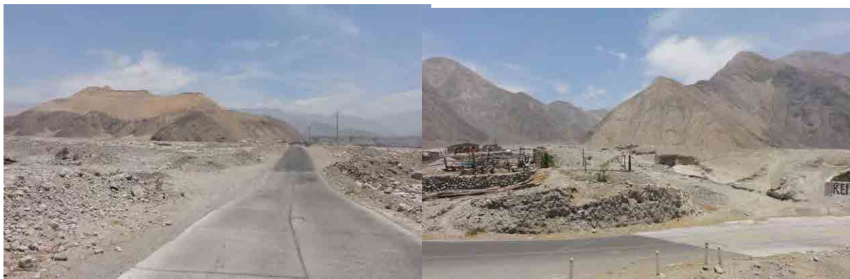
図-3.1.8-22 コソス川を通過する市道（雨期には土砂が市道を覆うが1日で復旧するとのこと）
