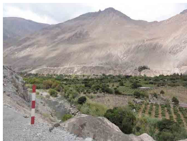
図-3.1.8-15 堆積岩類の土砂生産状況
