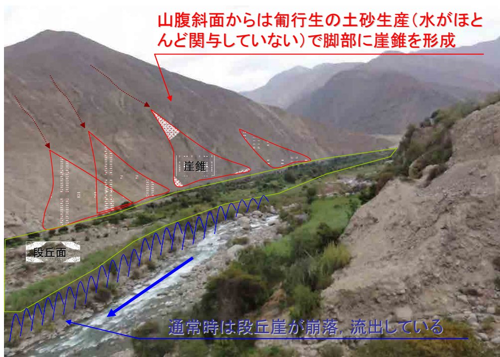
図-3.1.8-17 河道付近における土砂移動
