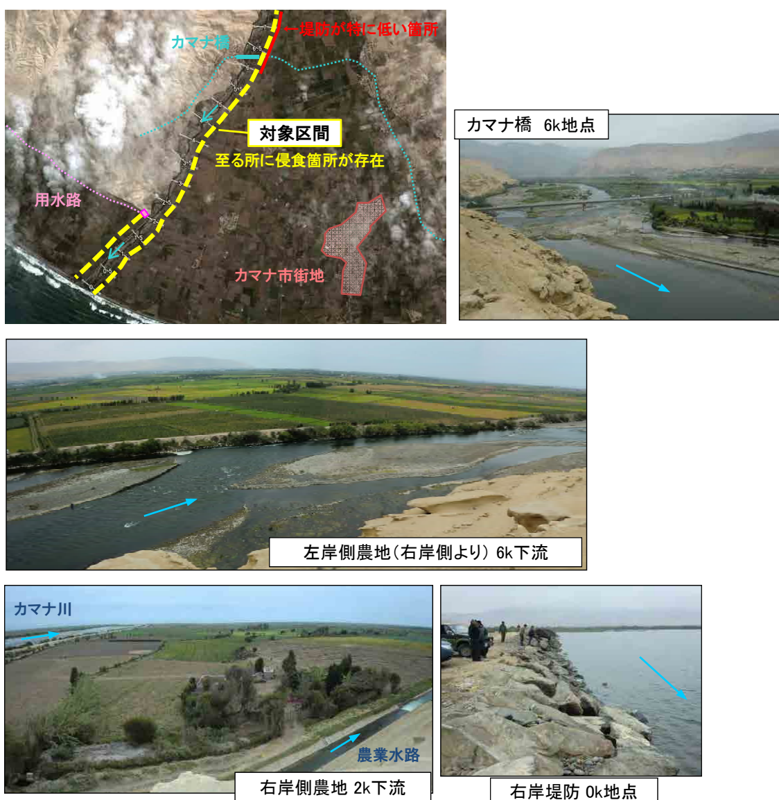
図-3.1.6-23 課題1に関する現地状況（カマナ川）
