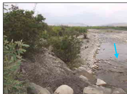
再構築された堤防の状況
