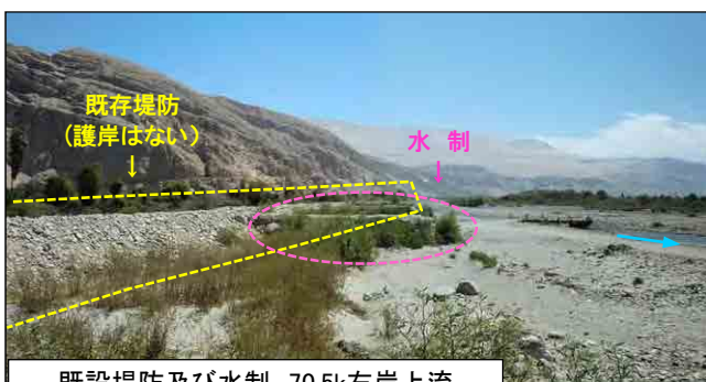
既設堤防及び水制 70.5k右岸上流
