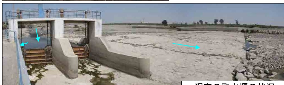
現在の取水堰の状況
