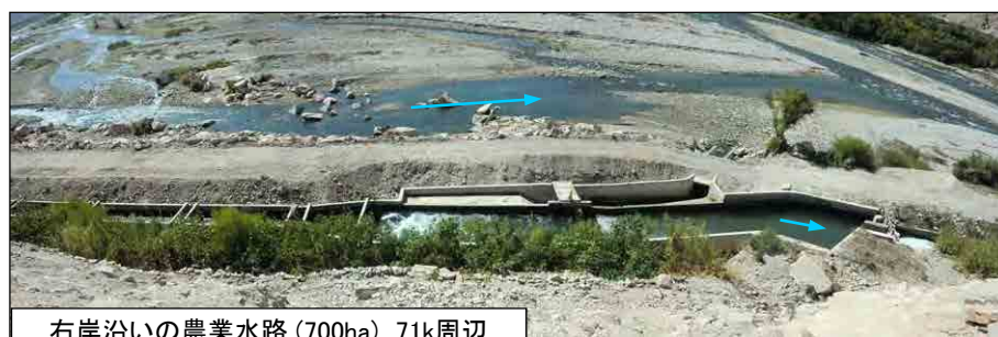
右岸沿いの農業水路(700ha) 71k周辺
