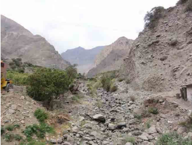
図-4.6-3 安山岩質～玄武岩質の崩壊地
