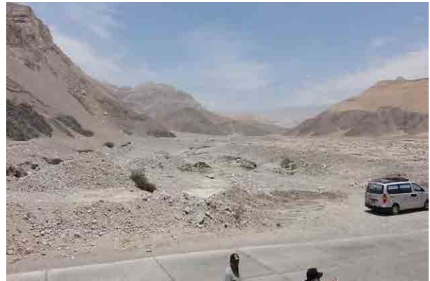
図-4.6-8 90 k m 付近右支川のコンス川の土砂堆積状況 (幅約 900m)
