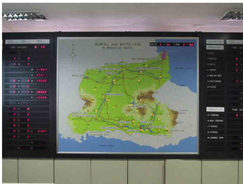
写真 2.2.2 PJT1 内の河川情報室
