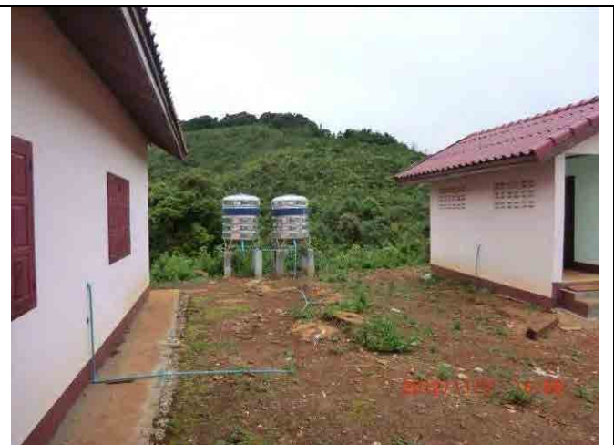
既存給水タンク
