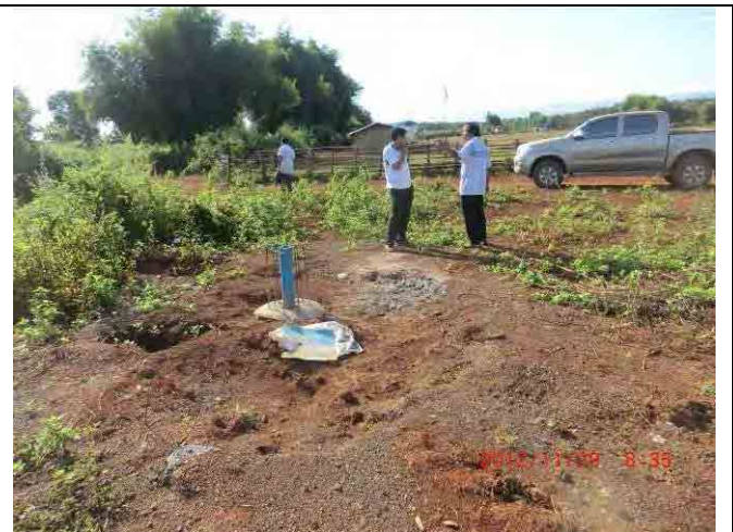
新敷地 試掘済み井戸、学校の隣地である
