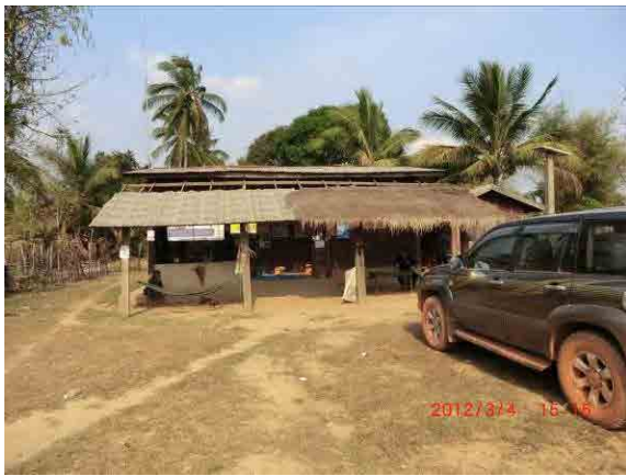
老朽化している既存施設。既存施設はそのまま、新保健センターは近くの新敷地に建設。 (アタプー県 A-04 Sompoi 保健センター)
