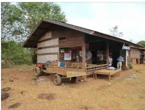
老朽化している既存施設。既存施設はそのまま、新保健センターは同敷地内に建設。 (サラワン県 S-01 Naxay 保健センター)
