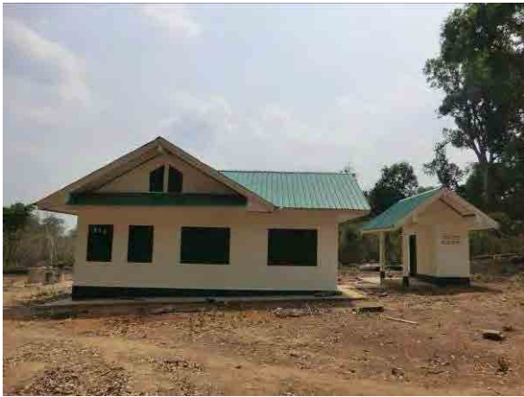
アタプー県による保健センターの外観 宿舍の建設を計画する。 (アタプー県 A-15 Pak Bo 保健センター)
