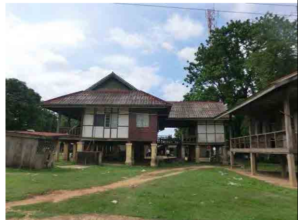
老朽化している既存施設。既存施設はそのまま、新保健センターを同敷地内に建設。(チャンパサック県 C-02 Saphai 保健センター)
