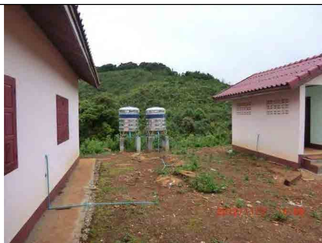
既存給水タンク
