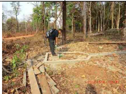
新敷地近接の村事務所用井戸
