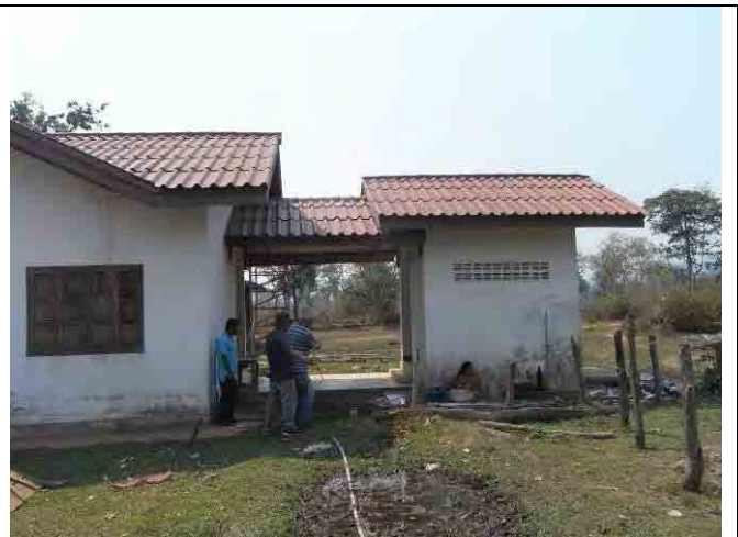
トイレ棟への渡り廊下は屋根付
