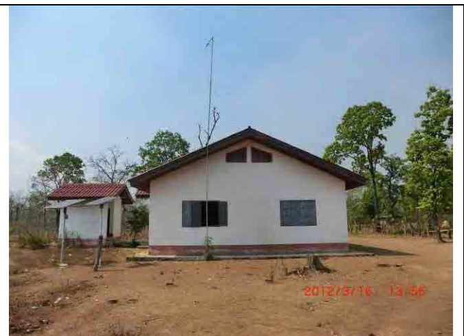
トイレ棟、ソーラー
