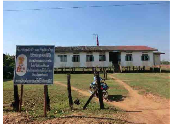
郡病院の建物を転用している保健センター。改修を要請している。 (チャンパサック県 C-14 Champasak 保健センター：施設は計画対象外)
