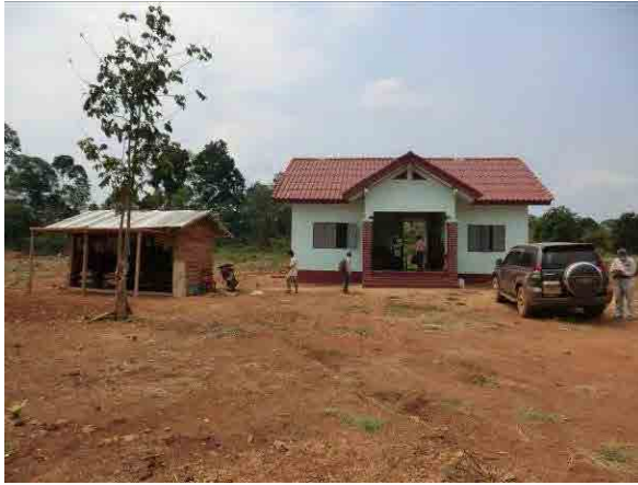
SFE (Service Fraternel d'Entraide) による保健センター 外観 (アタプー県、Saydonkhong 保健センター)
