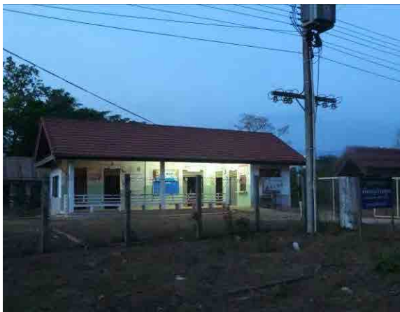
WB 支援による宿舎併設保健センター 外観 (アタプー県、Oudomsouk 保健センター)
