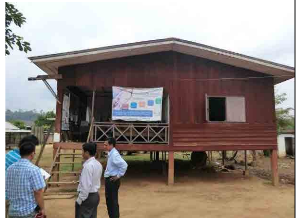
既存保健センターは老朽化し、また村の中心部からのアクセスが悪いため移転する。 (セコン県 X-08 Nongkan 保健センター)
