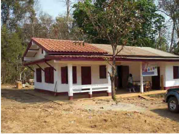
UNICEF の援助により一部の建物を改修している保健センター。 (アタプー県 A-01 Bengphoukham / Lak52 保健センター：施設は計画対象外)
