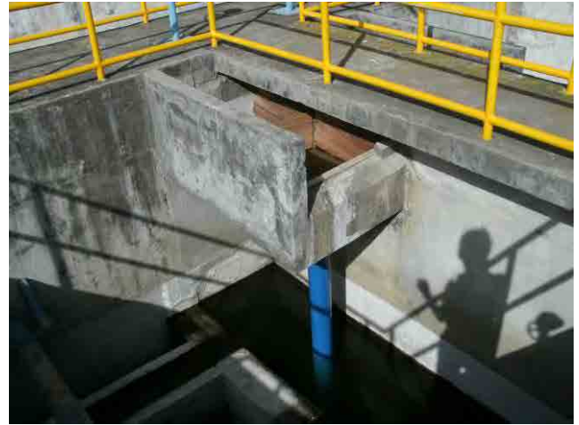
改修後 ろ過池：フロック破壊防止のため、流入用配管を設置した。
