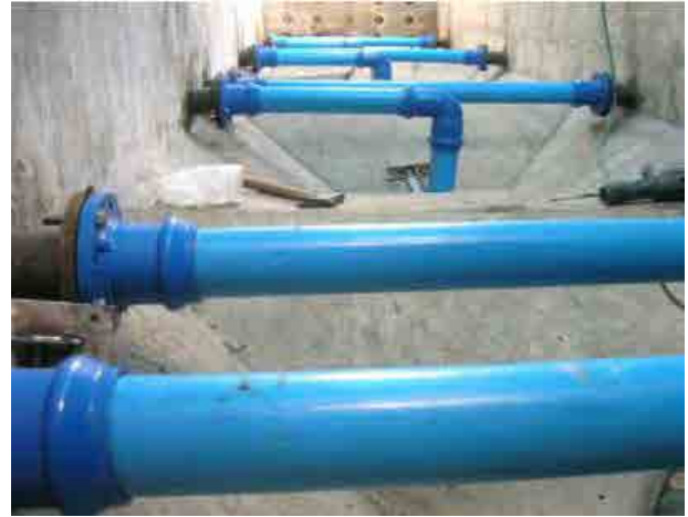
改修後 沈殿池：腐蝕部を PVC 管に交換し、適切な引拔が可能となったと共に、腐蝕の恐れが無くなった。
