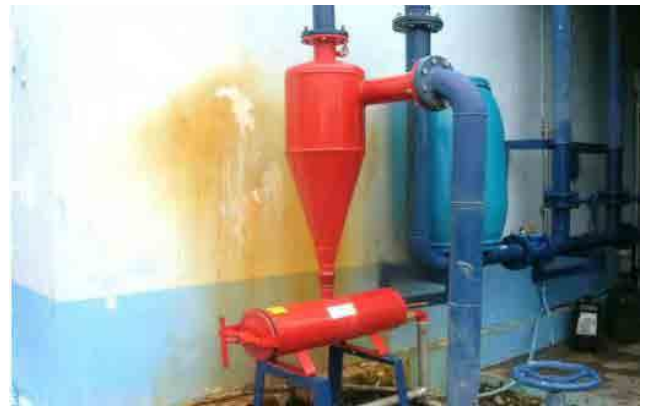
改修後 除砂器：新規にサンドセパレーターが設置され、除砂機能も有効になった。
