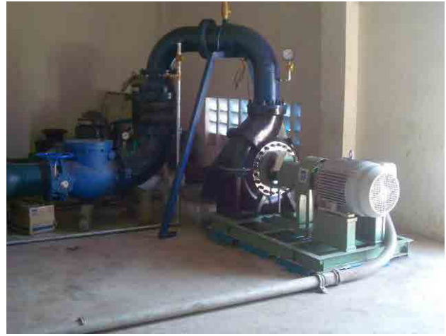
改修後 逆洗ポンプ：耐蝕製の陸上ポンプが設置され、適切に逆洗ができるようになった。
