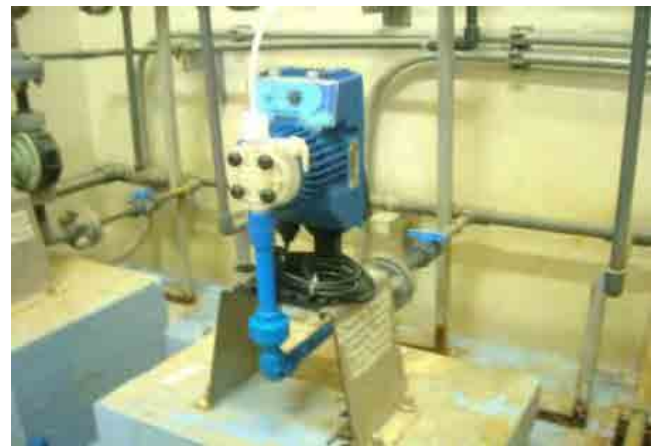
改修後 後塩素注入ポンプ：ポンプが更新され、後塩素注入が可能となった。
