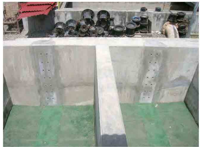
改修後 汚泥乾燥床：砂利・砂を充填すると共に、嵩上げを行い、貯留容量を確保した。
