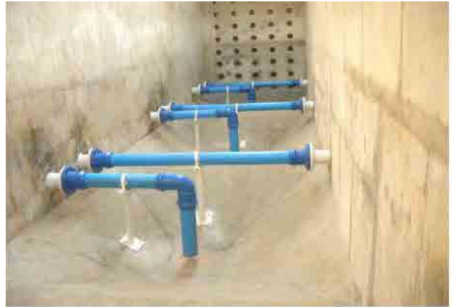
改修後 沈殿池：腐蝕部を PVC 管に交換し、適切な引抜が可能となったと共に、腐蝕の恐れが無くなった。
