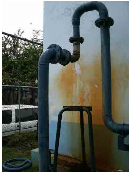
改修前 除砂器：2回交換したが、穴が開いたため取り外した。
