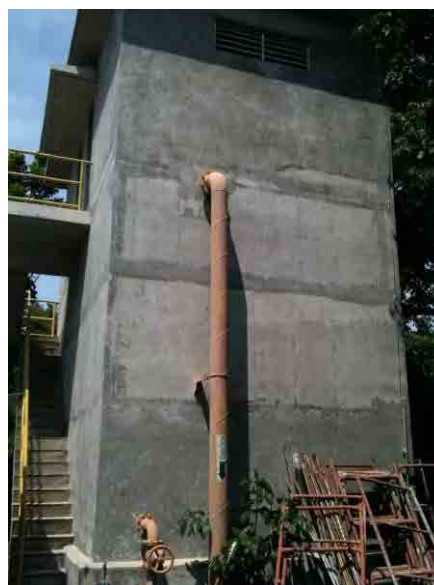
改修後 曝気塔：塗装除去が完了し、美観上の問題は無くなった。
