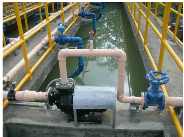
改修後 沈殿池汚泥引抜設備：汚泥引抜用の自吸式ポンプおよび配管を設置し、適切に運転することが可能となった。
