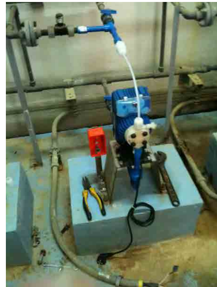
改修後 後塩素注入ポンプ：ポンプが更新され、後塩素注入が可能となった。
