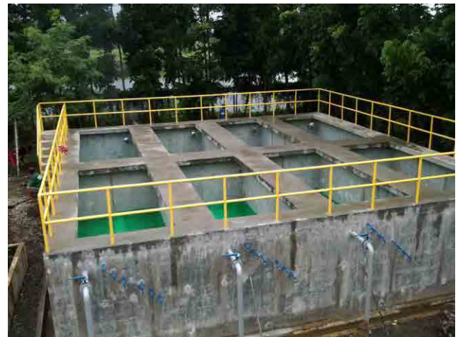
改修後 汚泥乾燥床：汚泥乾燥に必要な容量を新設したことにより適切な汚泥処理が可能となった。
