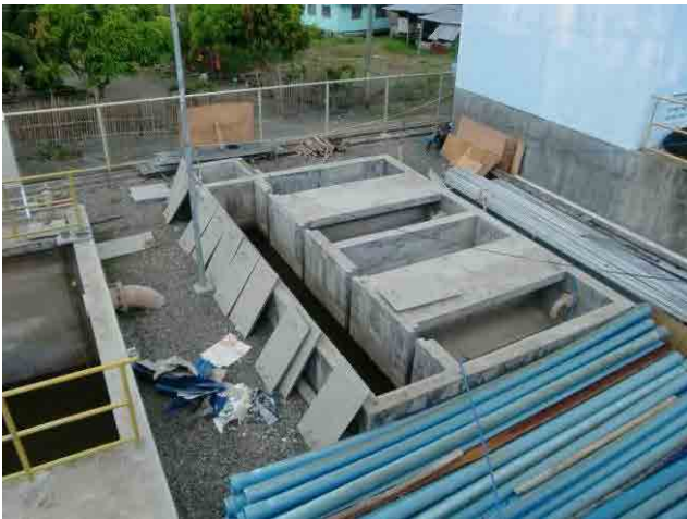
改修前 汚泥乾燥床：比国排水基準の変更に伴い、汚泥乾燥床としての機能を持たせるため、砂利等を充填する。
