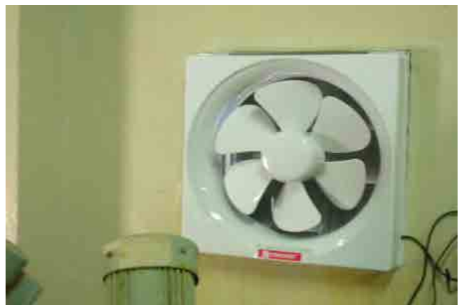
改修後 塩素室換気扇：交換を行い、換気が可能となった。
