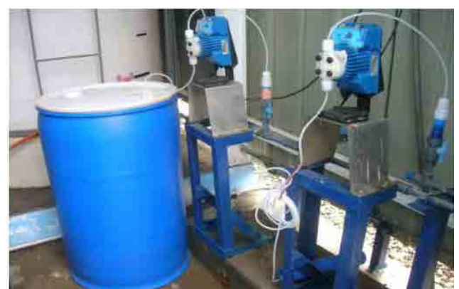
改修後 塩素注入ポンプ：新規にポンプが設置され、各点での塩素注入が可能となった。
