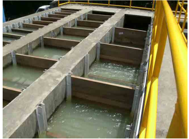
改修後 上下流式フロック形成池：う流板の調整により流速が増した。
