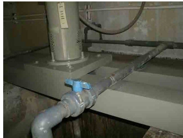
改修後 塩素攪拌機支持台：木製の支持台に交換し、耐久性が増した。
