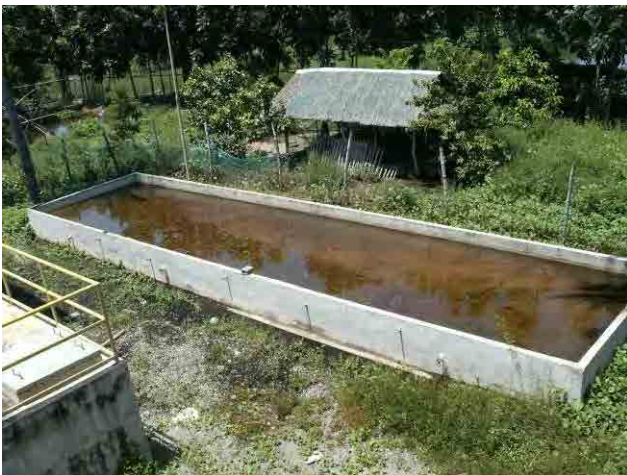
改修前 汚泥貯留槽：WDにより建設された汚泥貯留槽。汚泥を乾燥させる構造ではなく、自然蒸発させる構造のため、乾燥に3~4週間程度必要である。
