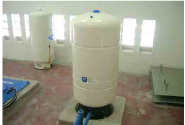
改修後 圧力タンク：圧力タンクを交換し、適切に使用できるようになった。
