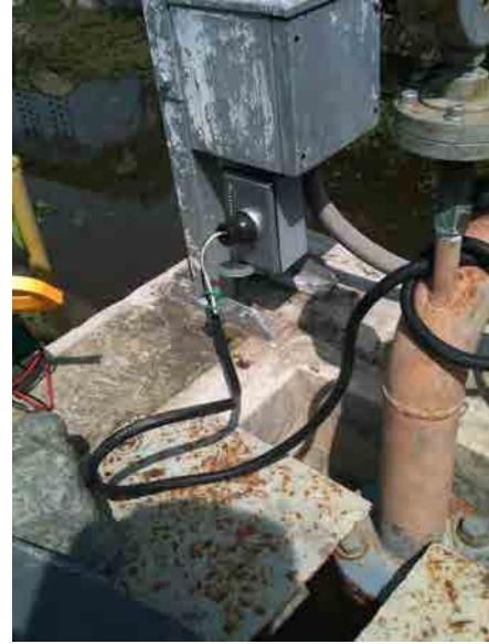
改修後 排水槽：屋外用の单相電源コンセントが設置され、維持管理性が向上した。
