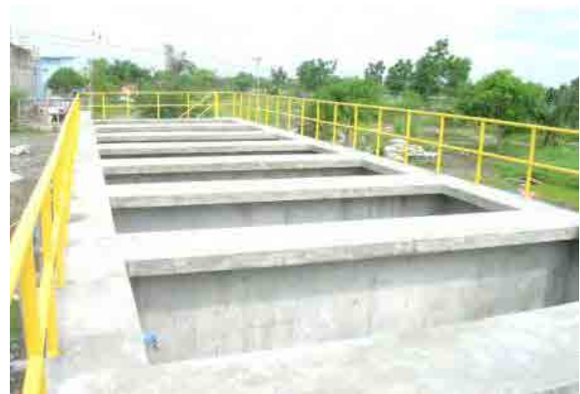
改修後 汚泥乾燥床：汚泥乾燥に必要な容量を新設したことにより適切な汚泥処理が可能となった。
