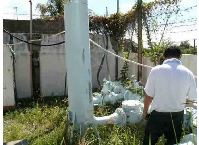
No.6 井戸：取水量が 24.4l/s と計画量 28l/s に近い。
