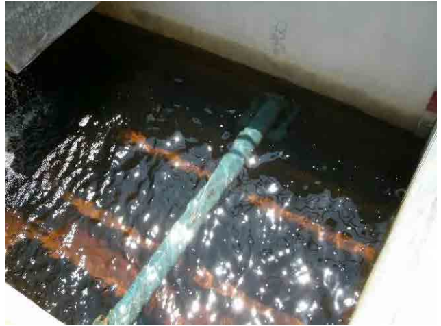
ろ過池：沈殿池では色度が除去できておらず、着色水となっている。
