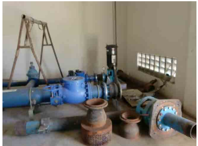
逆洗ポンプ：2009年10月頃に故障したため、ポンプを取り外した。
