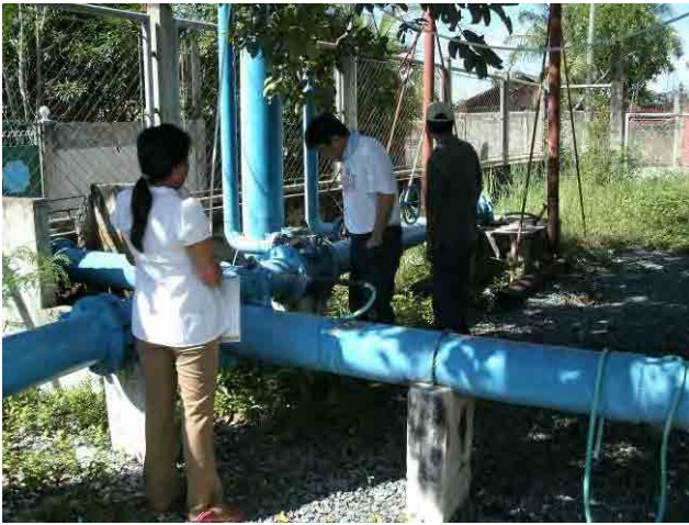
No.4 井戸：取水量が 11l/s と計画量 28l/s の半分以下。
