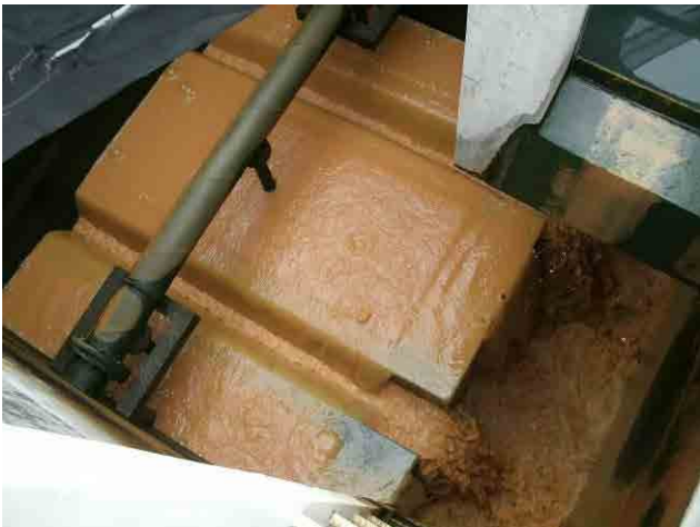
ろ過池：逆洗中。
