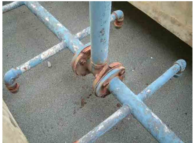
急速ろ過池：同左
