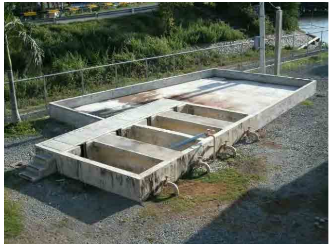
汚泥乾燥床：既存の汚泥乾燥床に WD 側で新たに増設している。
