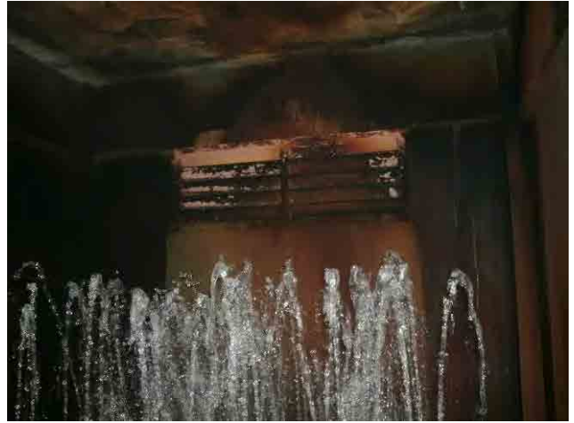
曝気塔：噴射が弱まり、天井まで届かなくなった。溶存酸素は十分であり、特に問題ない。
