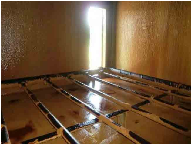
曝気塔：酸素濃度は十分にある。
