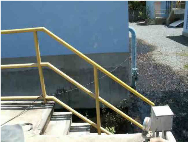
排水槽：故障した回収ポンプの代わりに購入したものは単相であるため、配水ポンプ室より延長コードにより単相電源を引き込んでいる。
