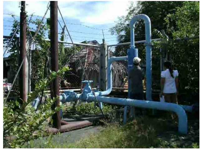
No.7 井戸：取水量が 10.5l/s と計画量 28l/s の半分以下。
