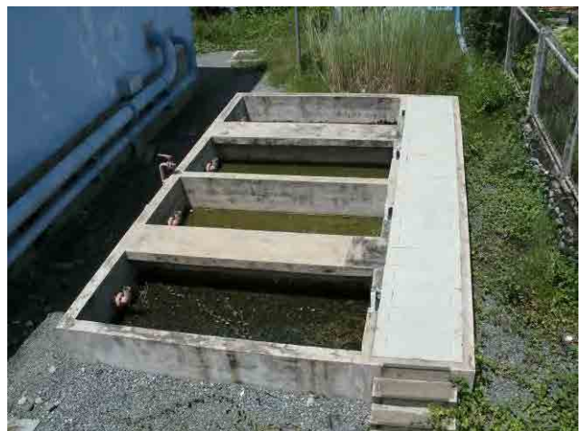
汚泥乾燥床：砂利が充填されているが、使用していない。
