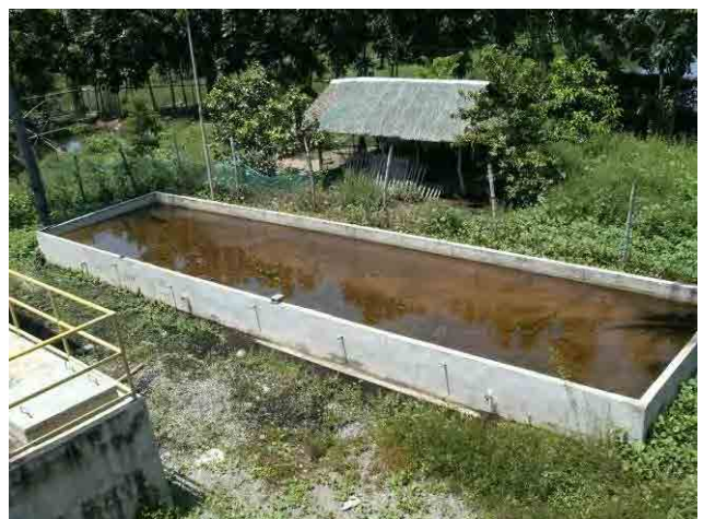
汚泥貯留槽：WD により建設された汚泥貯留槽。汚泥を乾燥させる構造ではなく、自然蒸発させる構造のため、乾燥に3~4 週間程度必要である。
