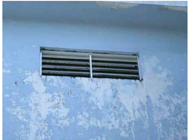
曝気塔：WDにより設置されたアルミ製ガラリ
