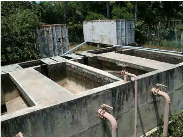
汚泥乾燥床：竣工後、砂利・砂を充填した状態で使用していたが、5回程使用した後、目詰まりが生じたため取り除いた。
