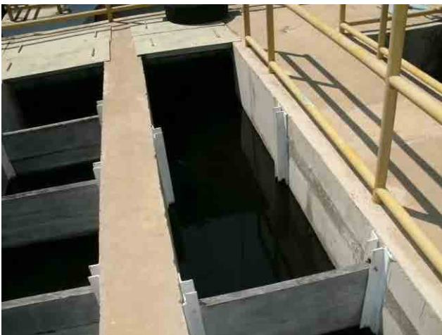
フロック形成池：清掃のため、最後尾の2列の阻流板を取り外している。
