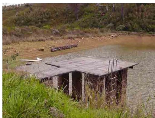
図 2.6 ため池と取水用のポンプ施設
