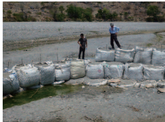
ラクロ川の河床低下に対応した土のうとフトン籠による導流堤
