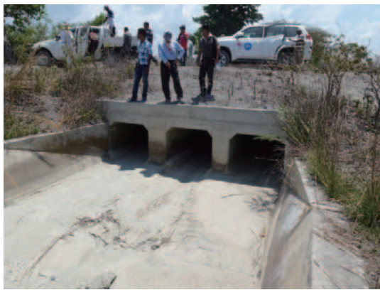
ラクロ川からの取水部分に砂礫が堆積している(取水工前部の鋼材は砂礫防止のためのゲート工事の実施途中)
