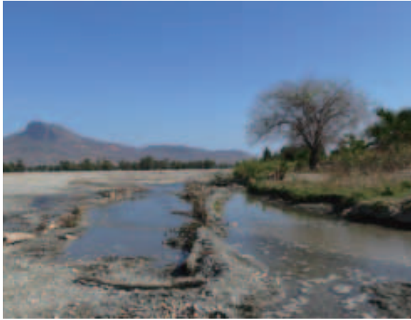
伝統的灌漑施設〔導流堤(スマセ灌漑地区)〕
