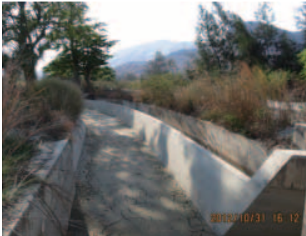
余水吐／幹線水路／ラクロ灌漑地区
