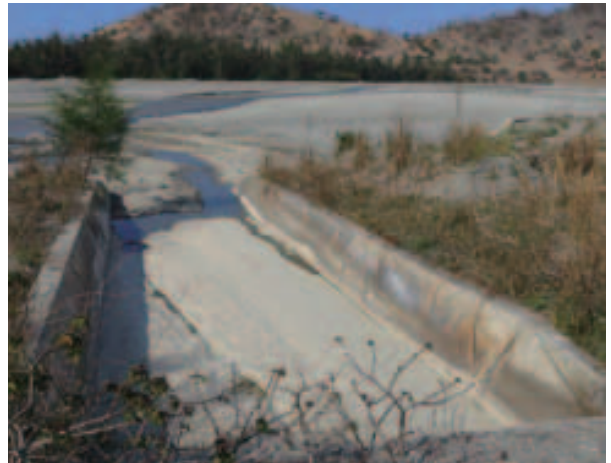
土砂吐／幹線水路／ラクロ灌漑地区
