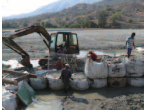
ディリマネ灌漑地区への取水口での蛇籠設置
