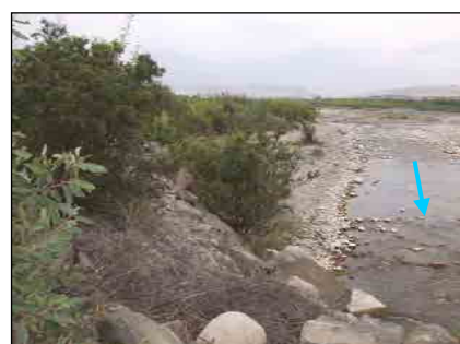
再構築された堤防の状況
