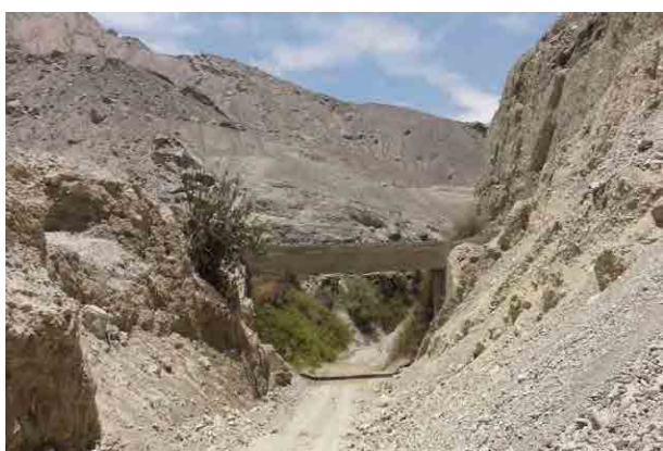
図-3.1.8-24 サンフランシスコ川の土砂堆積状況（灌漑水路が土石流により被災した。道路側壁はその時の土石流堆積物）
