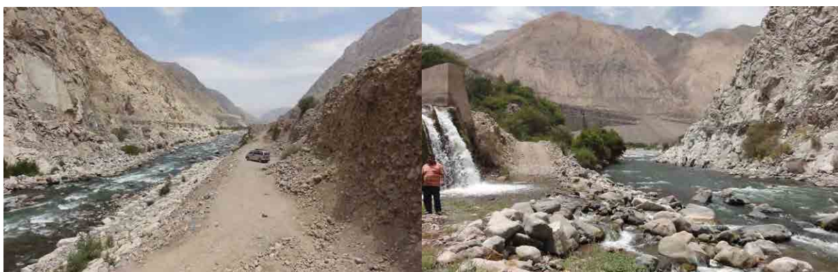
図-3.1.8-26 河口から110km付近の状況（斜面からの河道への土砂流入は僅かであると推定できる）
