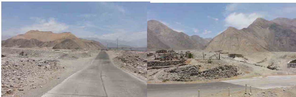
図-3.1.8-22 コソス川を通過する市道（雨期には土砂が市道を覆うが1日で復旧するとのこと）
