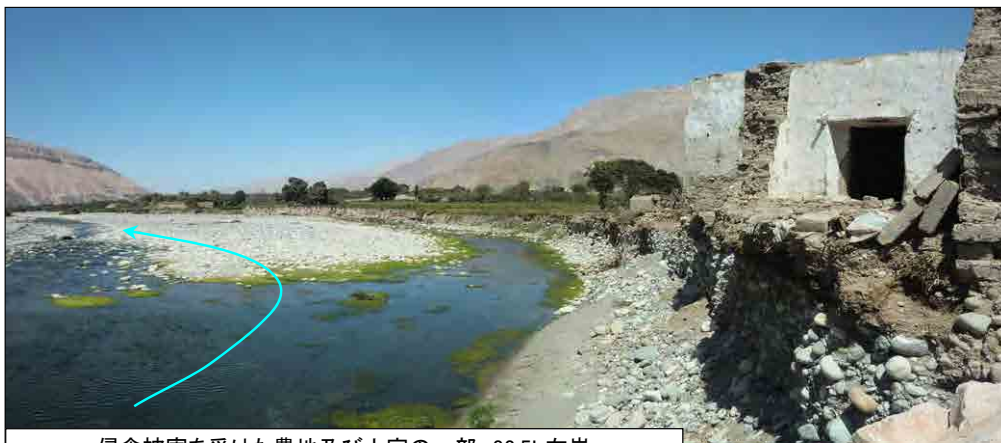
侵食被害を受けた農地及び人家の一部 88.5k右岸
