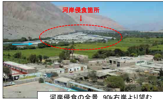
河岸侵食の全景 90k右岸より望む
