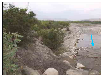
再構築された堤防の状況
