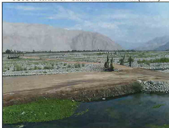
FOTO N° 66: MC-07 – Puente Rústico de Acceso (65+900)
