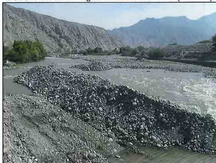
FOTO N° 24: Ch-03 – Aguas arriba Partidor Conta (> 24+000)
