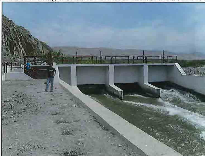
FOTO N° 8: Ca-03 - Margen Derecha Río Cañete – Bocatoma La Fortaleza (10+400)
