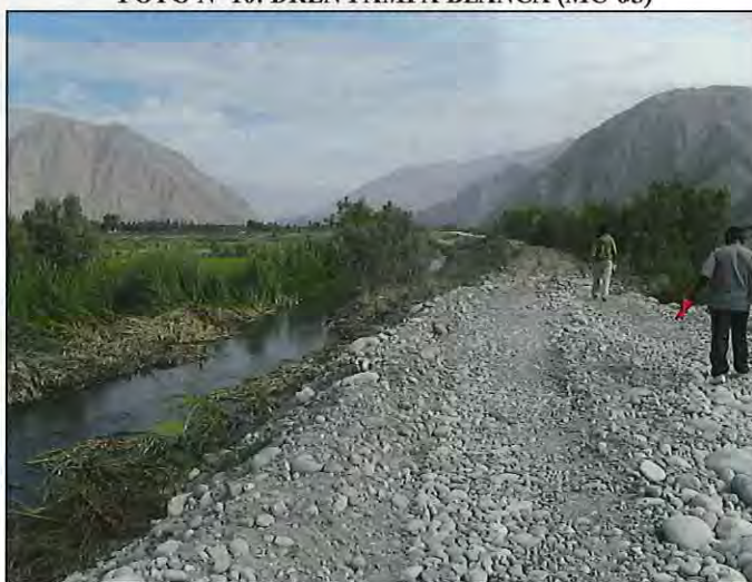
FOTO N° 10: DREN PAMPA BLANCA (MC-05)
