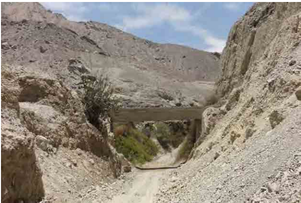
図 1.3.11 サンフランシスコ川の土砂堆積状況（灌漑水路が土石流により被災した。道路側壁はその時の土石流堆積物）
