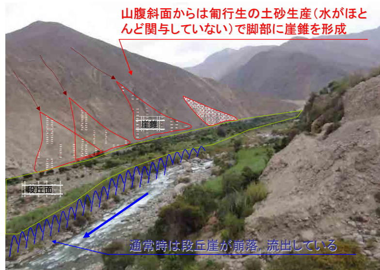
図 1.3.4 段丘面の侵食状況
