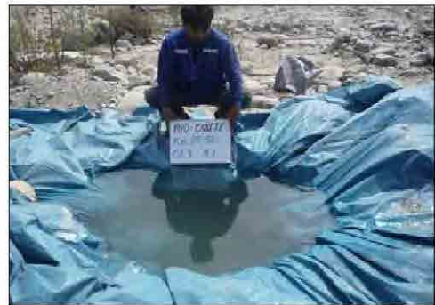
Llenado de agua a la calicata para determinar el volumen excavado
