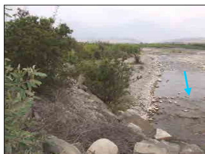
再構築された堤防の状況
