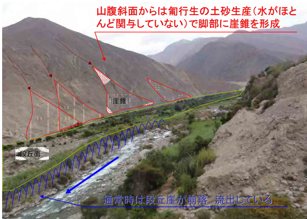
図-3.1.8-15 河道付近における土砂移動
