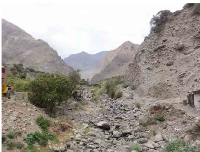
図-3.1.8-12 安山岩質～玄武岩質の崩壊地
