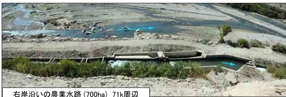
右岸沿いの農業水路(700ha) 71k周辺
