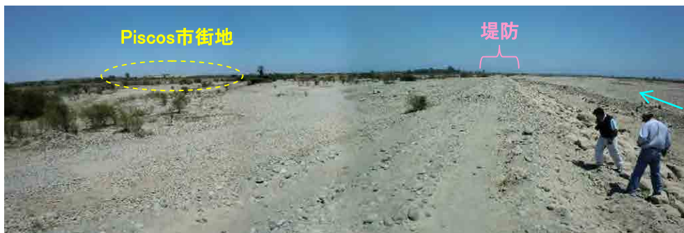
氾濫地点付近の現況堤防
