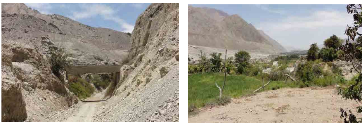
図-3.1.8-22 サンフランシスコ川の土砂堆積状況（灌漑水路が土石流により被災した。道路側壁はその時の土石流堆積物）
