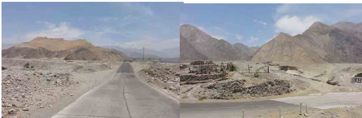
図-3.1.8-20 コスス川を通過する市道（雨期には土砂が市道を覆うが1日で復旧するとのこと）
