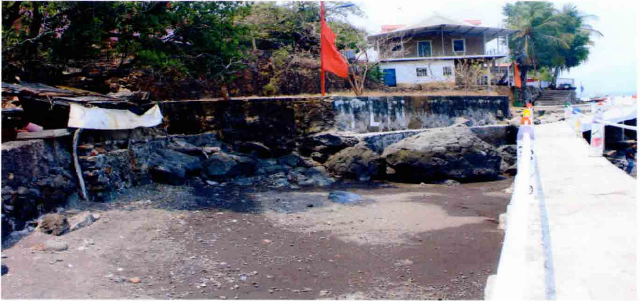
SE PRETENDE RELLENAR ESTA AREA PARA LA COLOCACION DE RESTAURANTES
