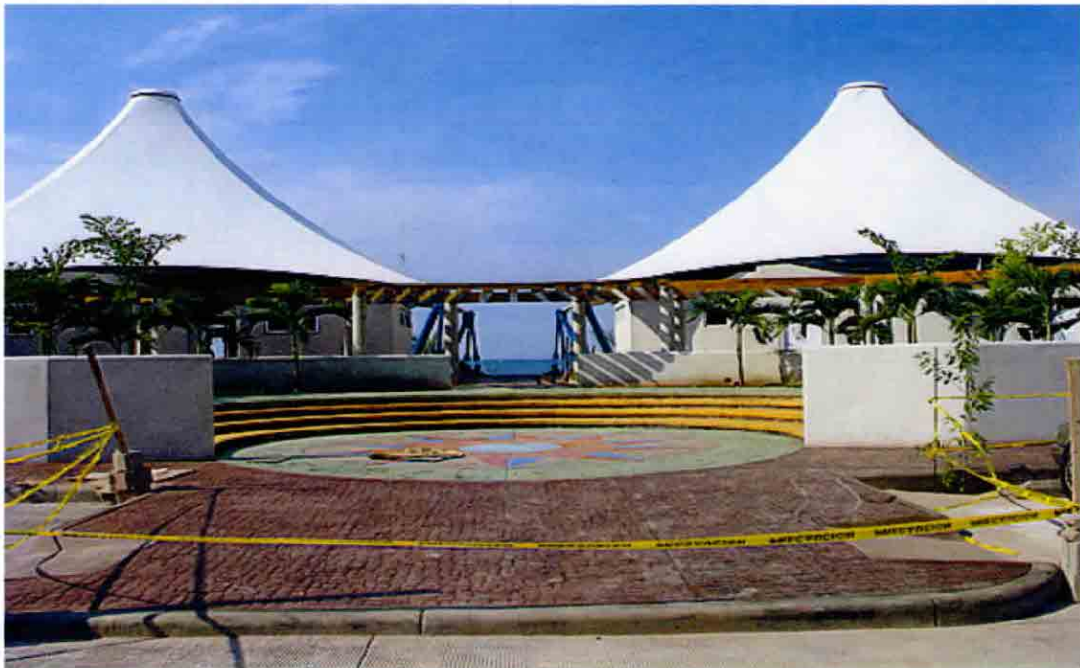
SE CONSTRUIRA UN ANFITEATRO
