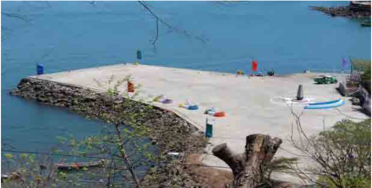
SITUACION ACTUAL DEL MALECON
