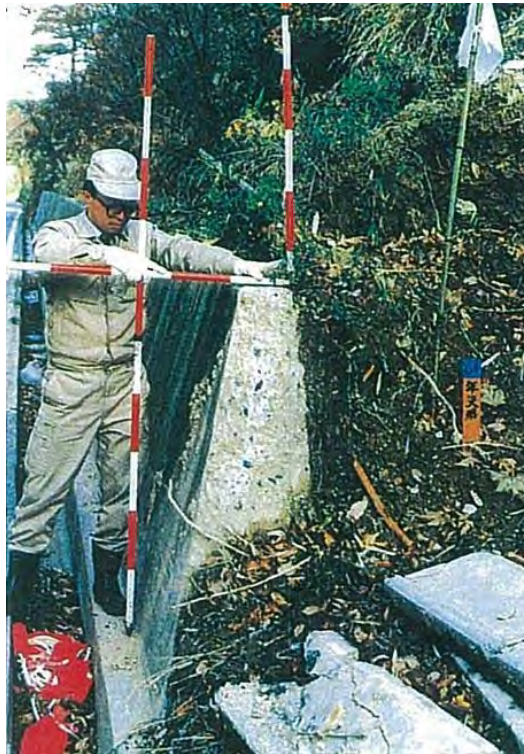
ภาพถ่ายที่ 2.2.15 การตรวจวัดของหน้าตัดโครงสร้างเดิม
