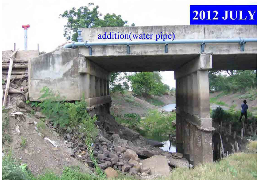
ภาพถ่าย 8.1-8 เปรียบเทียบการตรวจสอบสภาพการรื้อถอนสะพาน Pilot (1030-2)
