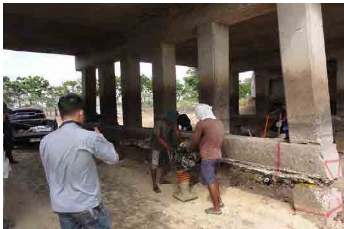
รูปภาพที่ 8.1-11 สภาพการควบคุมการก่อสร้างโดยเจ้าหน้าที่ BRR2 (1)
