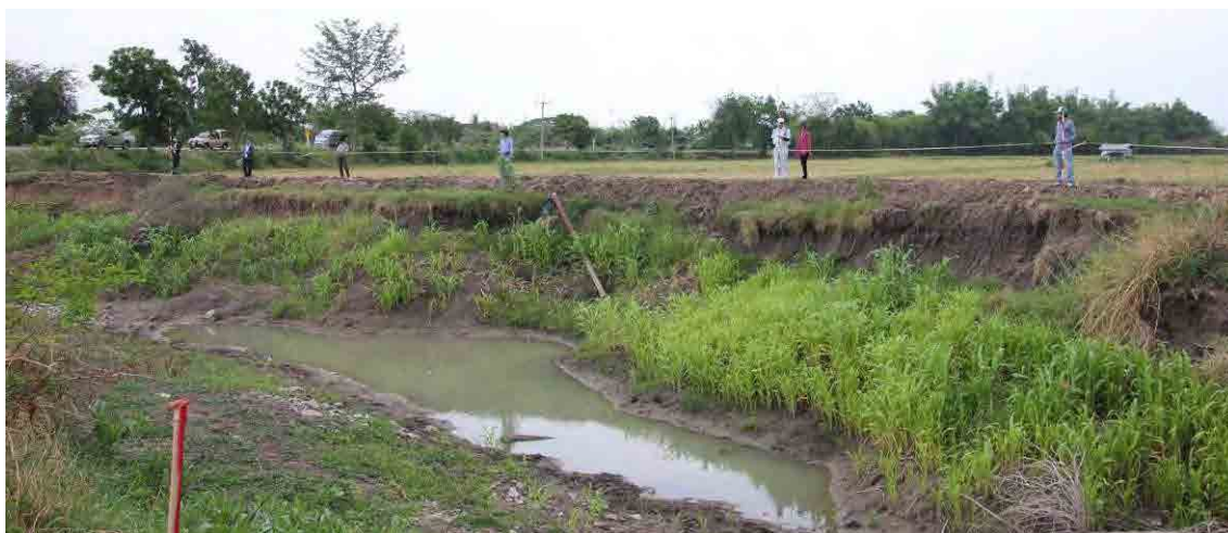
รูปภาพ 8.1-3 สภาพการวัดขอบเขตความเสียหายด้วยเทป
