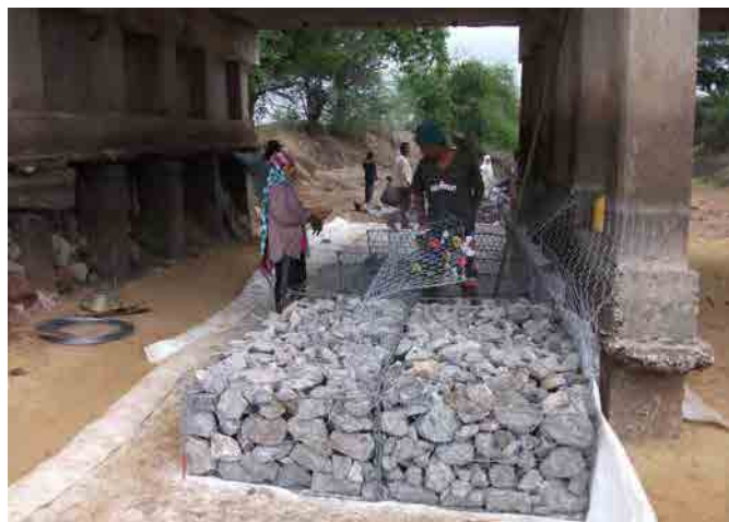
รูปภาพที่ 8.1-12 สภาพการควบคุมการก่อสร้างโดยเจ้าหน้าที่ BRR2 (2)
