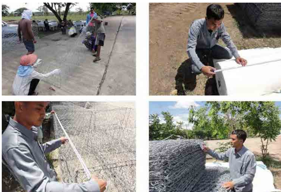
รูปภาพที่ 8.1-10 บรรยากาศการให้คำแนะนำและตรวจเช็คการประกอบ Gabion โดยเจ้าหน้าที่ BRR2
