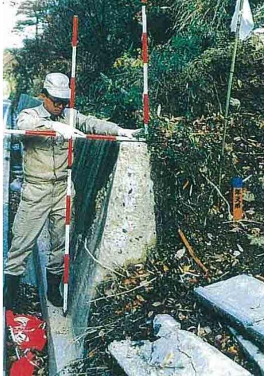
写真 2. 2. 15 既設構造物断面の測定
