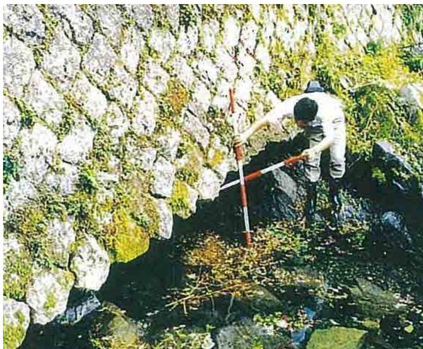
写真 2. 2. 14 空洞化状況の測定
