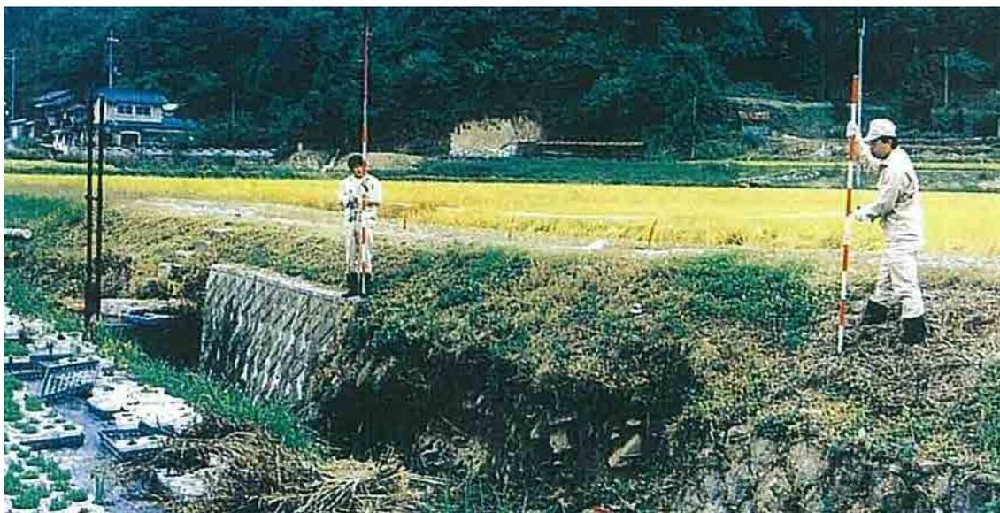
写真 2.2.5 ポール、巻尺（赤布きれ併用）による被災延長測定 の例
