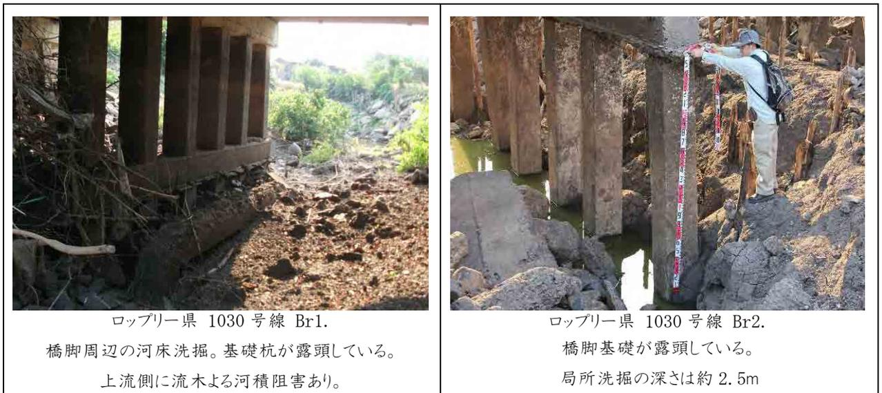
写真 7.3-1 河床洗掘による基礎杭の露頭
