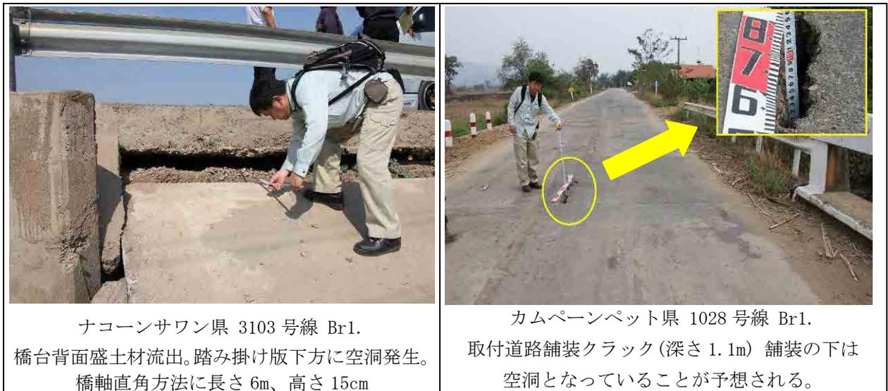
写真 7.3-3 取付道路舗装沈下・クラック及び空洞発生
