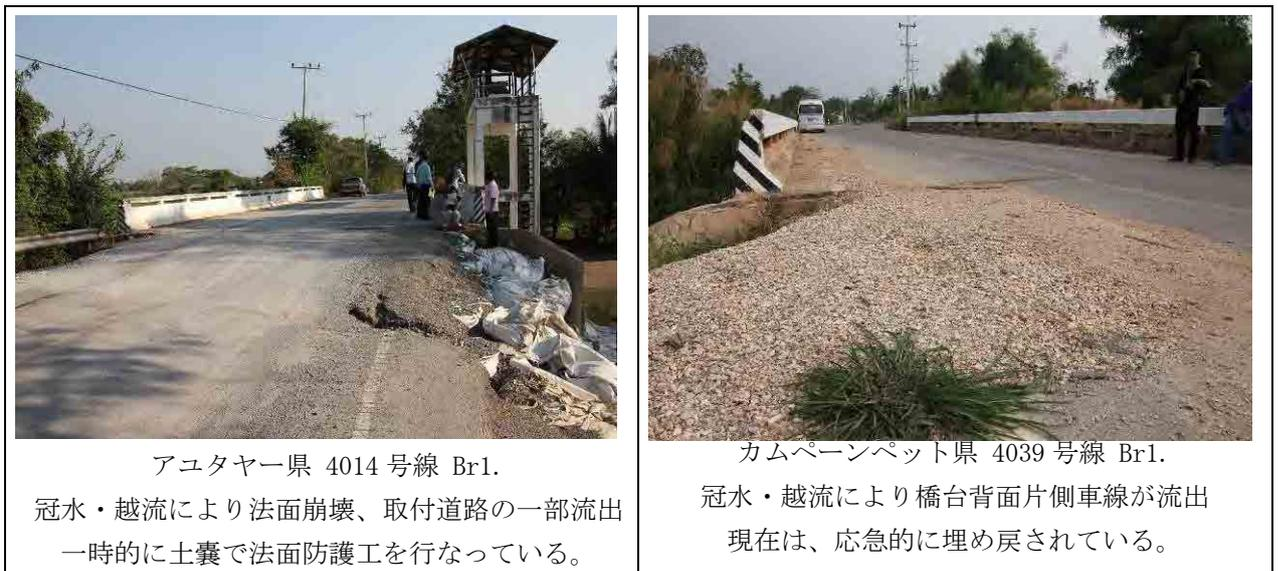
写真 7.3-4 取付道路流出及び法面浸食・崩壊
