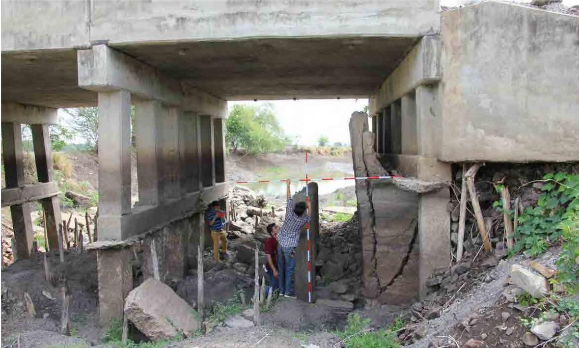
写真 8.1-5 河床洗掘、既設橋台・基礎杭残置の測定状況
