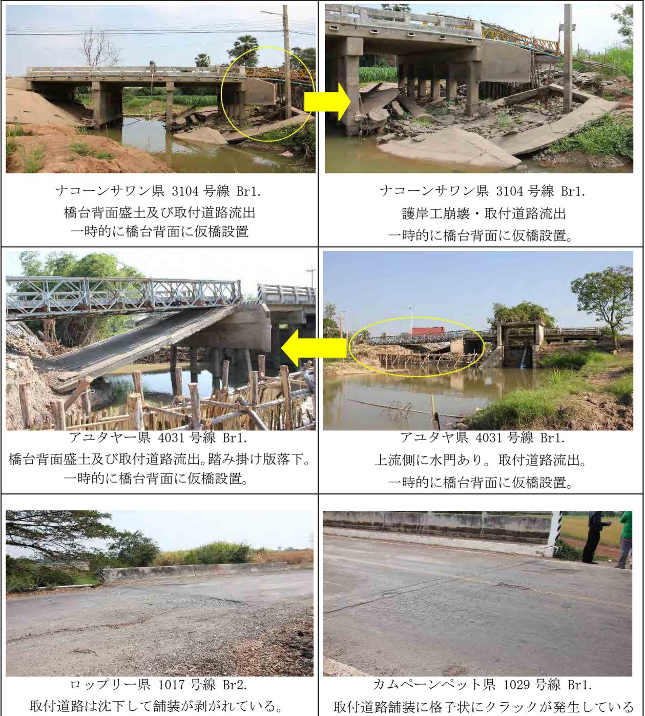
写真 7.2-6 取付道路沈下・流出
