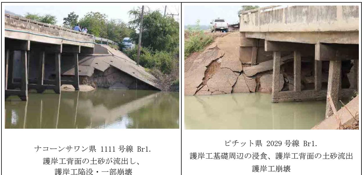
写真 7.3-2 橋台周辺護岸工の陥没・崩壊
