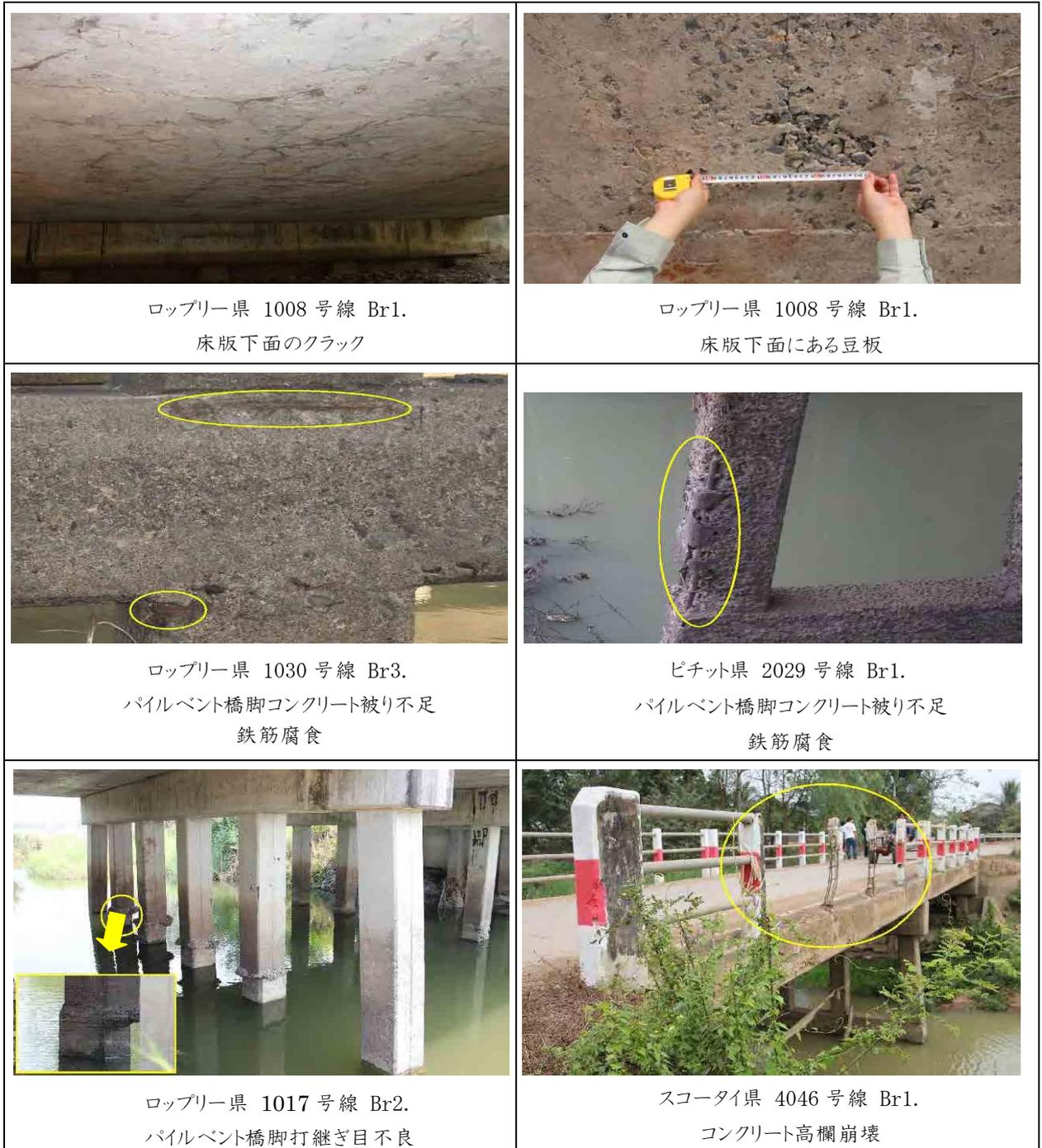
写真 7.2-9 洪水被害ではない損傷
