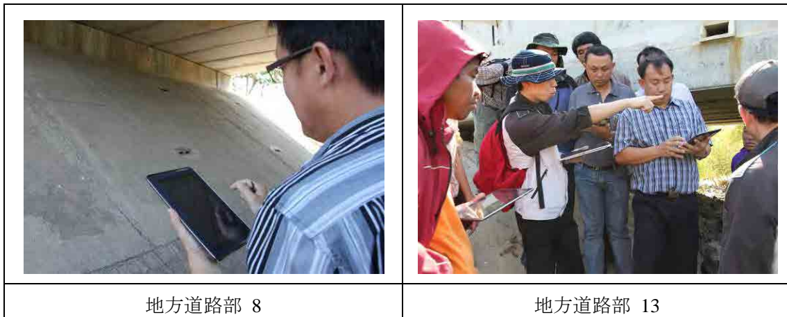
図 5.4-1 橋梁点検用タブレット PC を使用した橋梁点検
