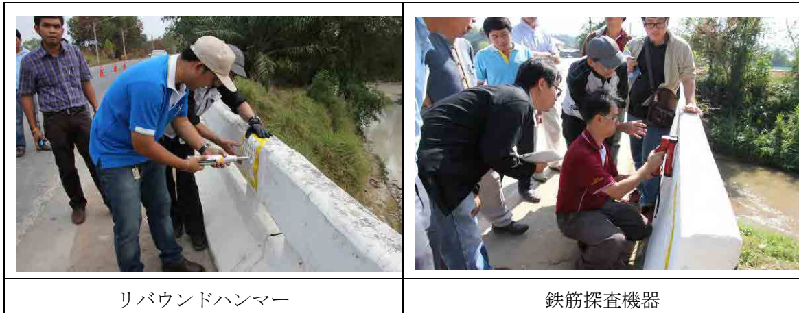
図 5.4-4 非破壊検査機器を使用した点検
