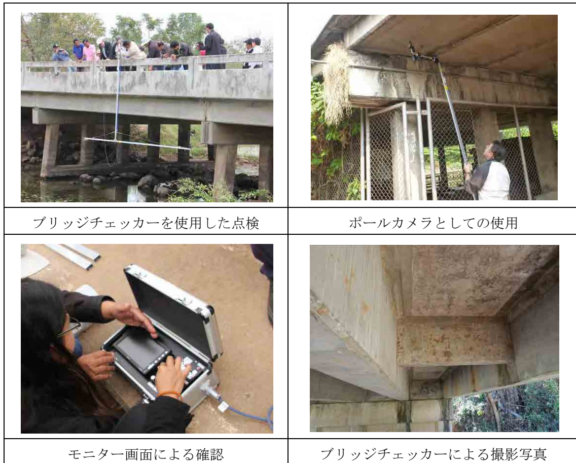
図 5.4-2 ブリッジチェッカー、ポールカメラを使用した点検
