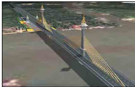
図1.4.16 ノンタブリー橋梁プロジェクト
