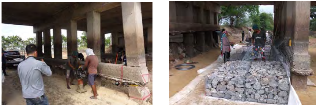
図 4.7-1 BRR2 職員による施工監理状況
