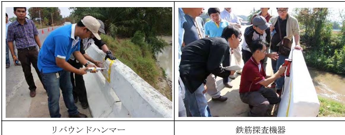
図 2.2-2 非破壊検査機器を使用した点検
