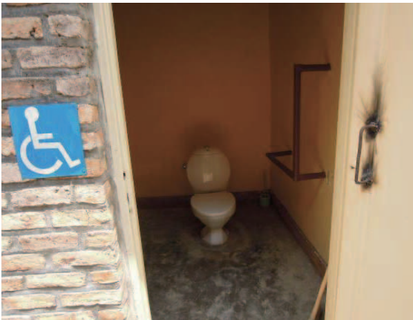
川内団員の指導で設置された取っ手（車椅子利用者が自力で開閉可能）（VTC Nyanza にて）
