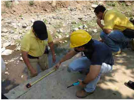
現場非破壊試験調査
