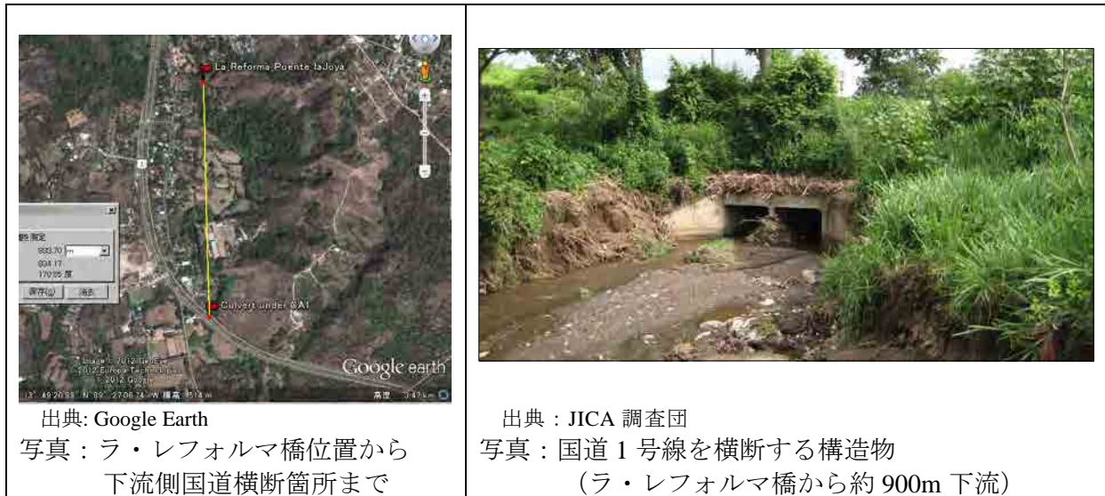
図 5.8.1 ラ・レフォルマ橋から約 900m 下流の国道横断構造物
