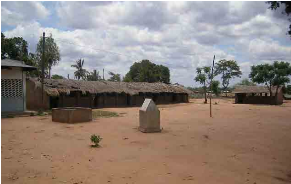
敷地から約 2.0 km に位置する既存小学校。茅葺 5 教室を含む 10 教室に 1,200 人を越える生徒がある。
