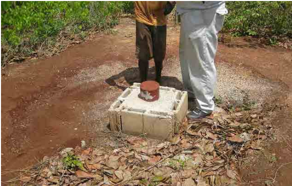
敷地内には本調査で 2 本の井戸が確保されている。2012 年 12 月時点の保全状態。
