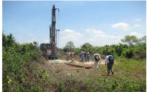
井戸掘削の様子。2 本の井戸からの給水を合せて計画施設に必要な給水を賄う。
