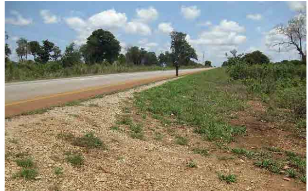
敷地南側を走る国道 8 号線。ナカラとナンブラを結ぶ主要道で整備状態は良好である。
