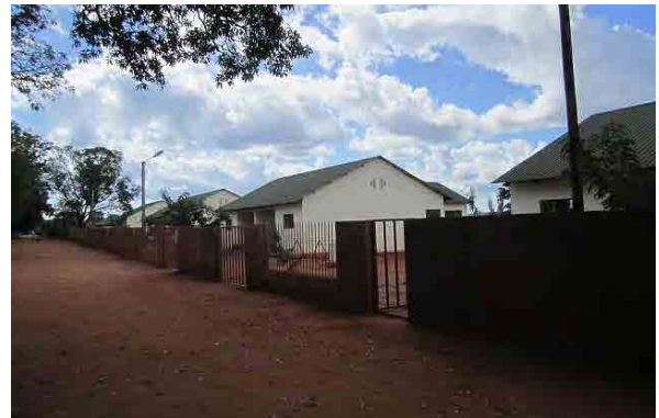
現地業者建設による標準的な施設。道路を挟んで反対側を居住ゾーンとして、学生寮と教員住宅が整備されている。
