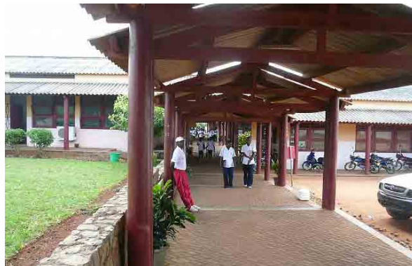
機能別に分かれた建物を渡り廊下で繋ぐ構成となっている。
