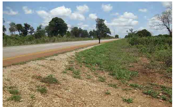
敷地南側を走る国道 8 号線。ナカラとナンブラを結ぶ主要道で整備状態は良好である。
