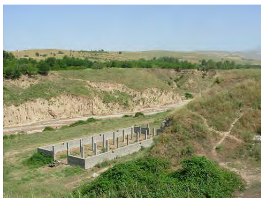
写真 3 - 1 建設中の加工工場
