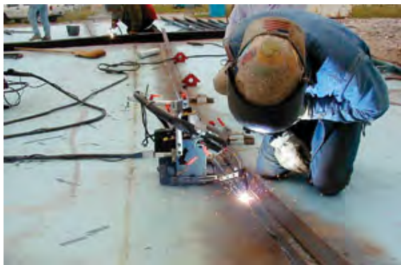
Photo- 1: Welding of LNG tank
