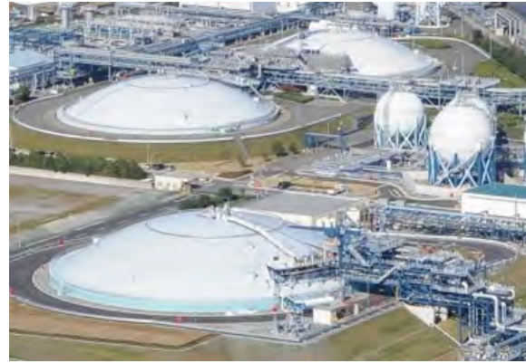
Photo- 25: Underground LNG tank
