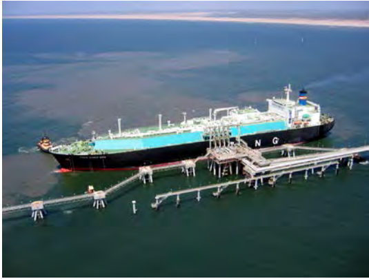
Photo- 12: LNG unloading arm
