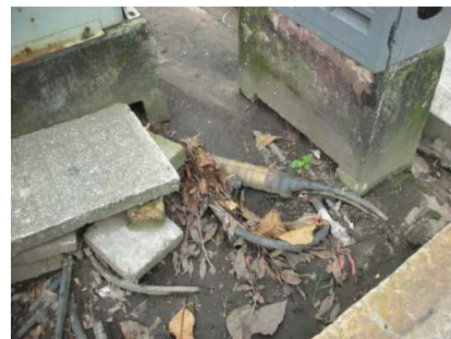
図 2.3.99: キャビネット実装状況およびクロージャー設置状況
