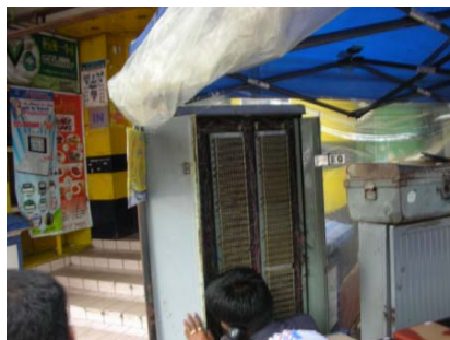
図 2.3.99: キャビネット実装状況およびクロージャー設置状況
