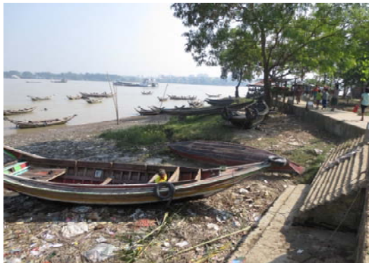
c) 地域の篤志家の出資により実施された 河岸保護工
