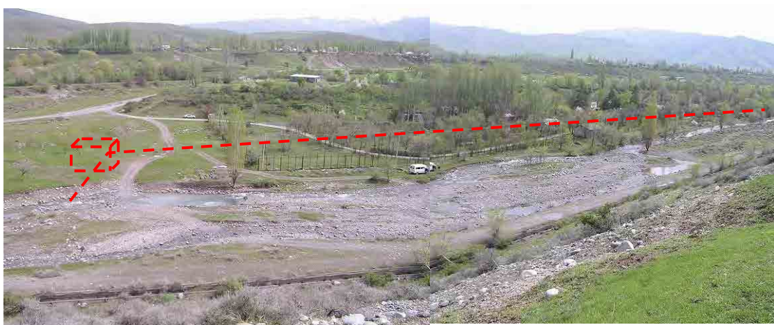
Photo 6-2-115: Powerhouse for Ak Suu-2
