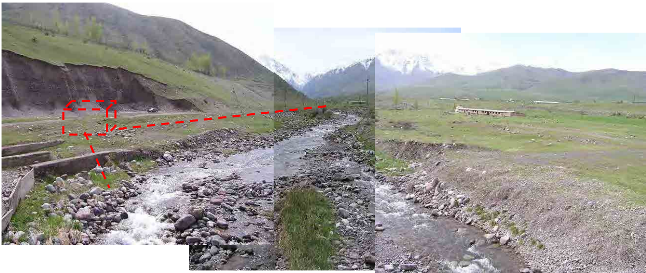
Photo 6-2-103: Ak Suu-1 Powerhouse
