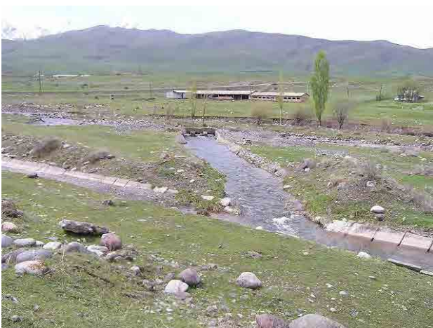
写真 6-2-104 自家発水力の取水地点
