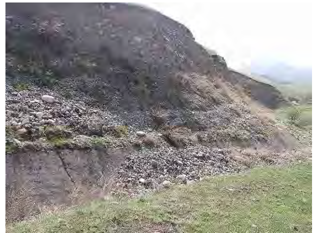
写真 6-2-61 斜面崩落と水路への土砂流入
