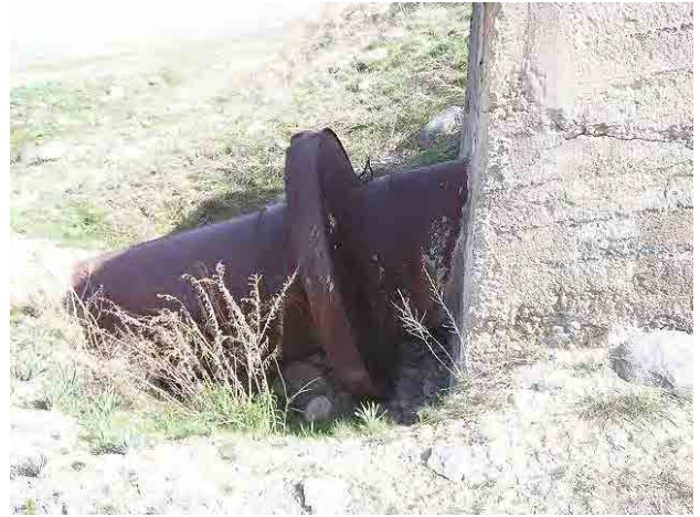
写真 6-2-57 水圧鉄管と固定台
