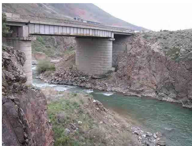
写真 6-2-6-97 Chon-Kemin-3 取水ダム下流の道路橋梁
