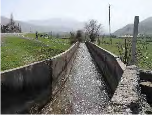
写真 6-2-89 取水口～発電所間の灌漑水路
