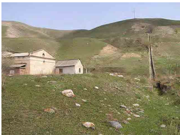
写真 6-2-54 発電所と水槽余水路
