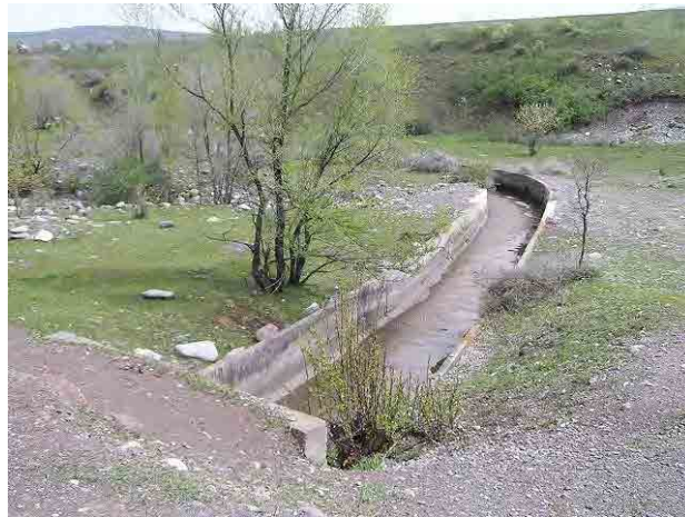
写真 6-2-114 Ak Suu-2 取水地点の灌漑取水設備に接続する灌漑水路
