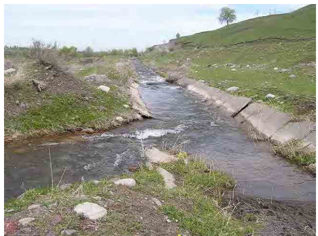
写真 6-2-105 自家発水力の取水地点付近導水路
