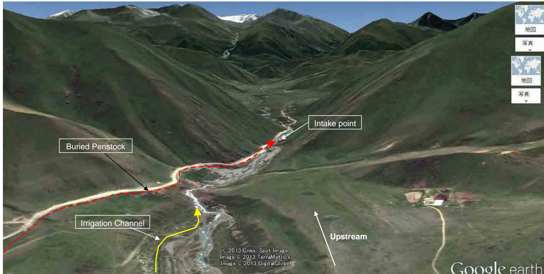
図 6-2-25 Shamsi 小水力取水口地点(下流側上方 (北側) から上流側 (東側) を望む)
