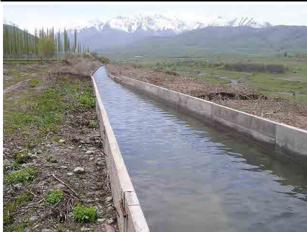
写真 6-2-106 自家発水力の導水路
