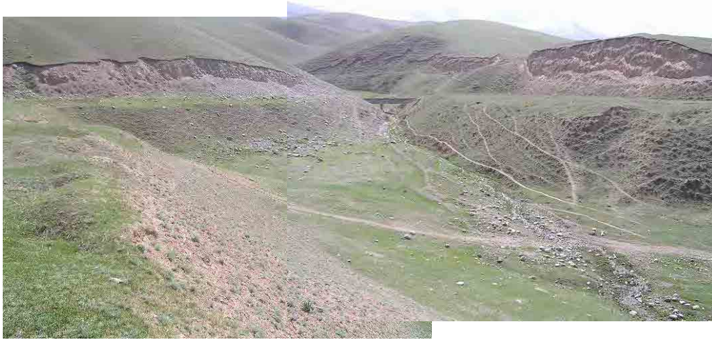
写真 6-2-62 導水路と水路橋
