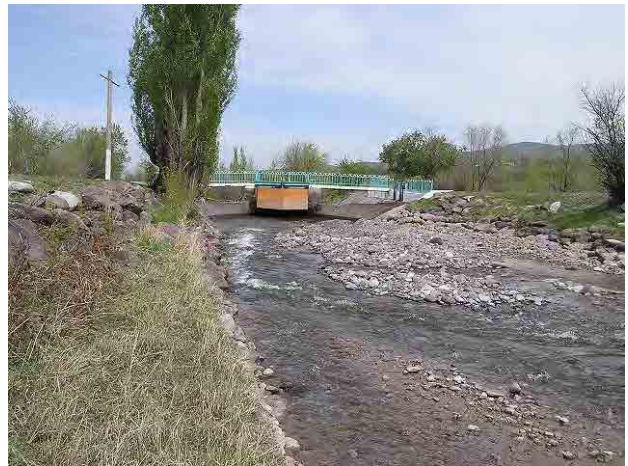
写真 6-2-113 Ak Suu-2 取水地点の灌漑 取水設備 Q=0.5 \text{ m}^3/\text{s} (目視)
