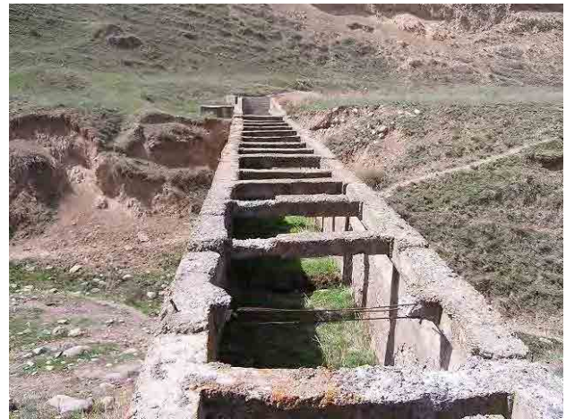
写真 6-2-64 水路橋 (断面 2 m x 2 m)
