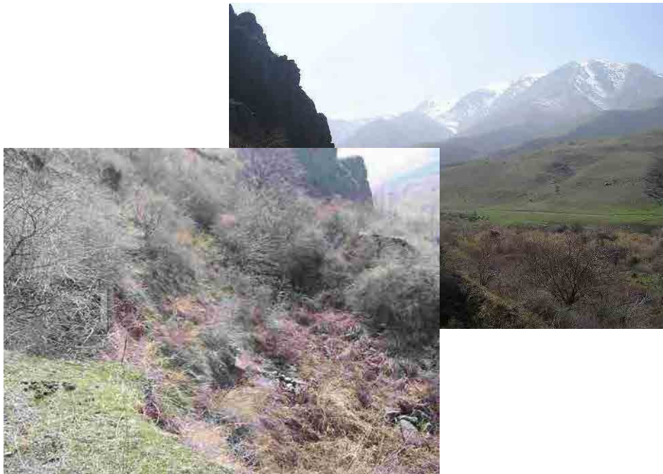
写真 6-2-40 導水路盤崩落箇所 2 (導水路も崩落) (水槽より 1,100 m 上流箇所)
