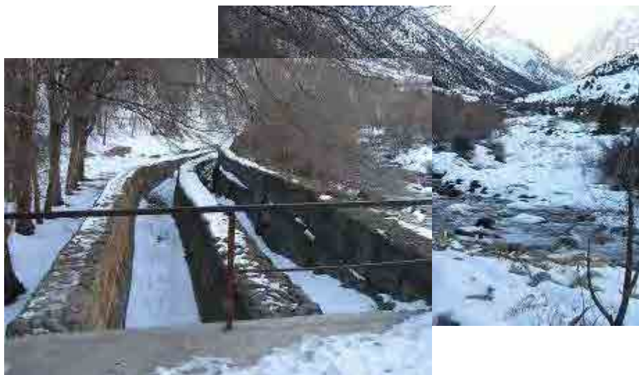
写真 6-2-48 Issyk-Ata-2 河川（右側）と旧発電所導水路開渠
