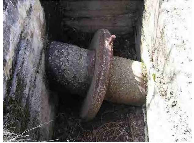
写真 6-2-27 水圧鉄管 (φ600)
