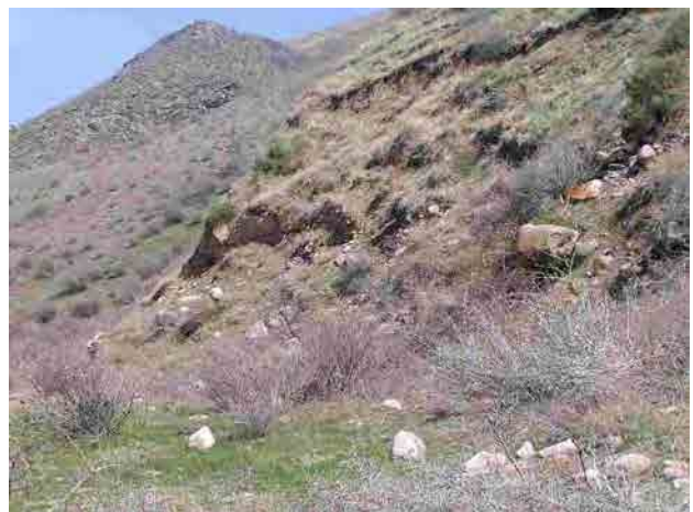
写真 6-2-42 導水路上方切土斜面の状況
