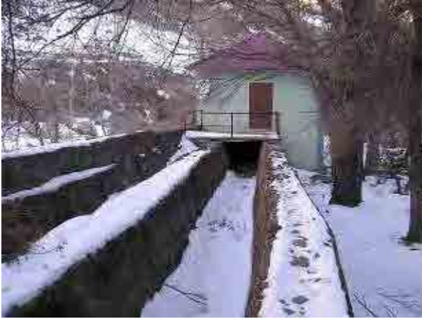
写真 6-2-49 旧発電所導水路開渠と保養施設
