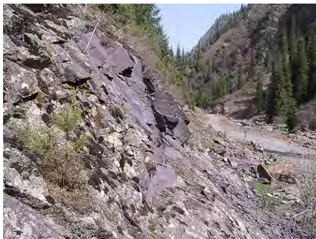
写真 6-2-5 A～B 地点間の道路斜面 (やや流れ目の岩盤摂理)
