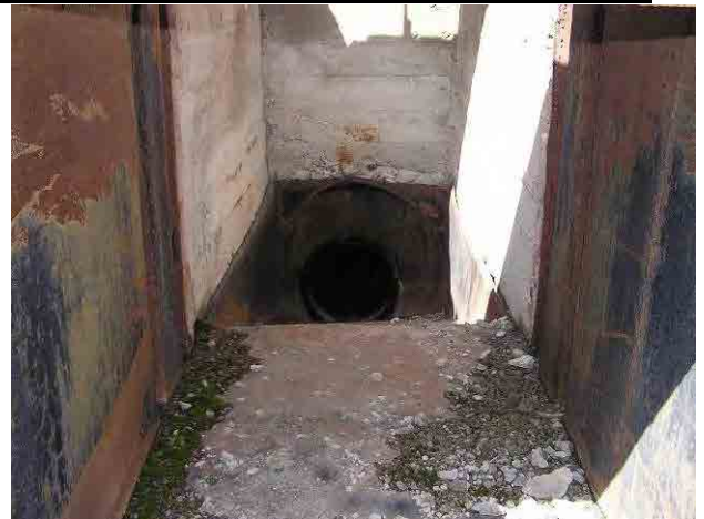
写真 6-2-31 水圧鉄管呑み口（水槽内部より）
