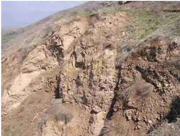
写真 6-2-36 導水路上部切土斜面の状況
