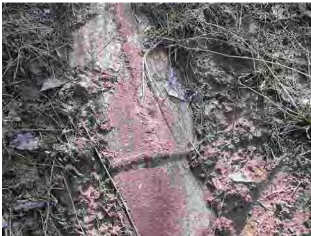
写真 6-2-26 水圧鉄管露出部 (φ600)
