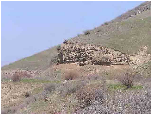
写真 6-2-41 導水路上方切土斜面の状況
