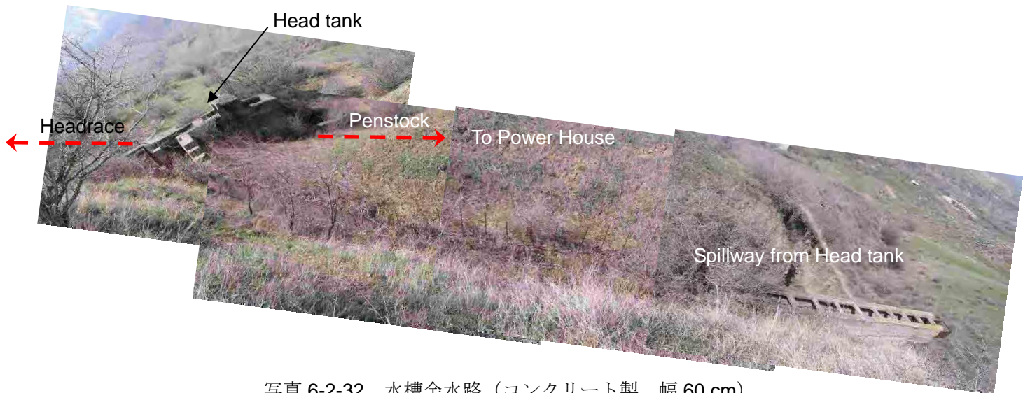
写真 6-2-32 水槽余水路（コンクリート製、幅 60 cm）
