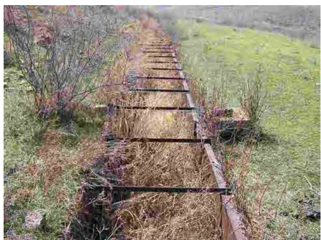
写真 6-2-34 導水路（幅 1 m、側壁 4 mm 鉄板）
