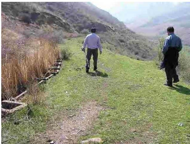
写真 6-2-33 導水路平地（幅約 5 m）
