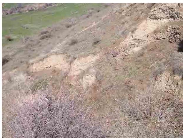
写真 6-2-37 導水路盤崩落箇所 1
