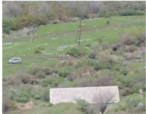
写真 6-2-47 10kV 配電線と旧発電所建屋 との位置関係
