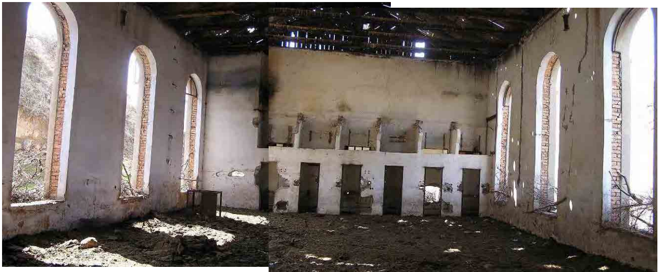
写真 6-2-23 発電所建屋内部
