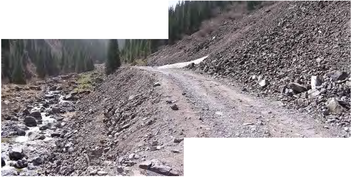
写真 6-2-7 A～B 地点間の道路切土（山側）斜面と盛土（川側）斜面
