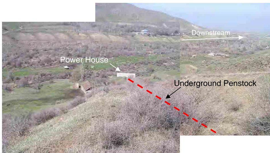
写真 6-2-29 水圧鉄管埋設斜面 (水槽付近から発電所建屋を望む)
