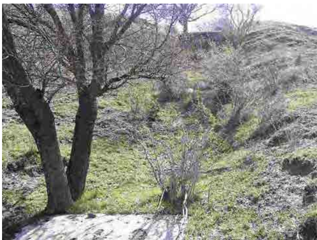
写真 6-2-24 水圧鉄管埋設斜面
