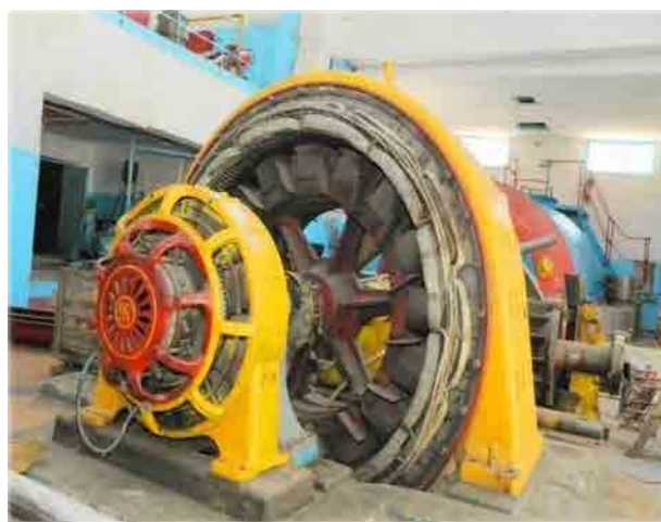
写真 3-3-1 不具合により停止中の Lebedinovka 発電所 No.2 ユニット発電機
