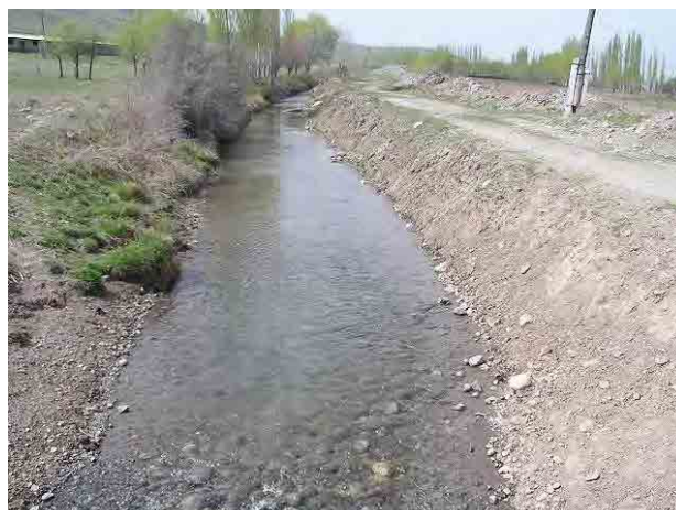
写真 5-7-7 Sokuluk-2 の開削導水路
