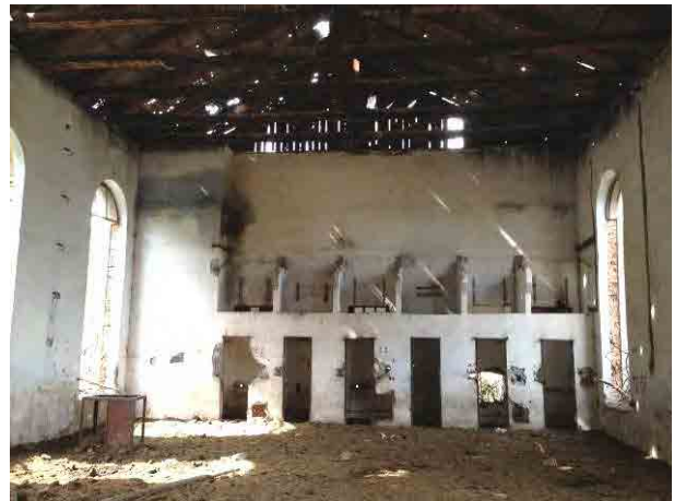
Djardy-Kainda： 旧発電所の建物の中は空洞になっていて、再開発時に処分しなければならない旧設備の廃棄物はない。
