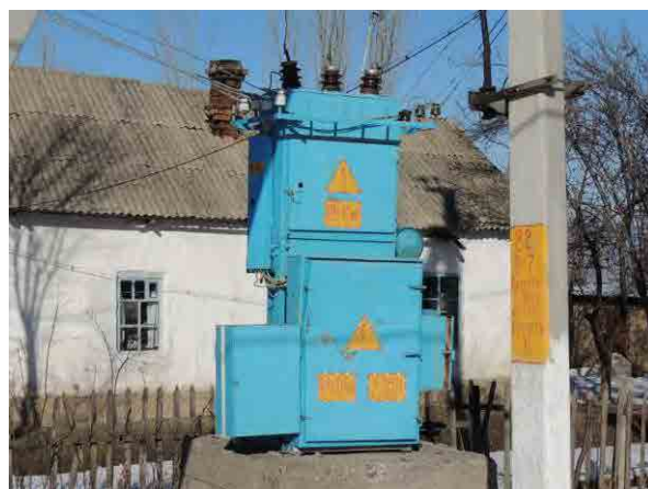
写真 5-4-1 10kV 配電線 (左) と 10/0.4kV 変圧器 (右) (Kegeti 村)
