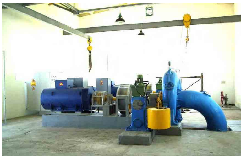
写真 3-3-2 Issyk-Ata 水力発電所の水車発電機
