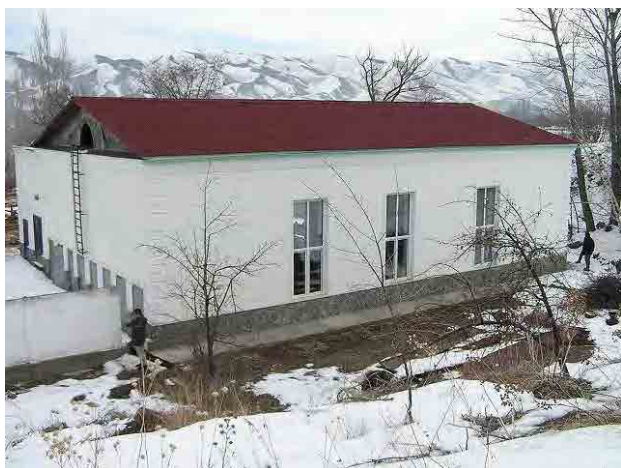
写真 5-7-9 : Sokuluk-2 発電所建屋外観
