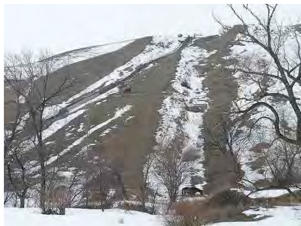
写真 5-7-8 Sokuluk-2 水圧管路・水槽余水路の斜面
