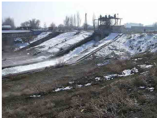
写真 5-7-12 Lebedinovka 発電所の バイパス放流設備
