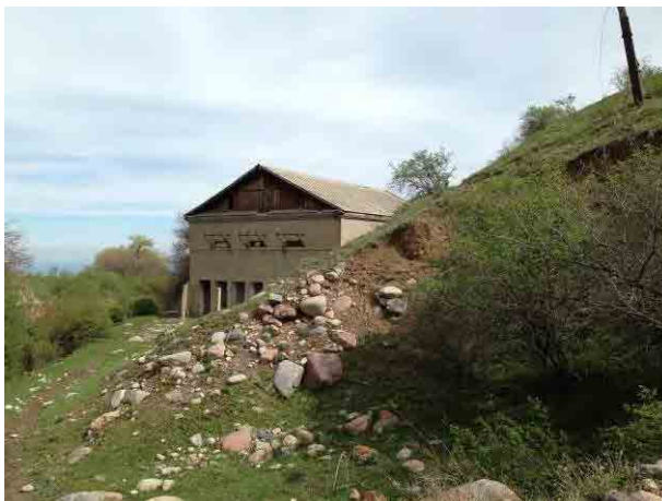
Djardy-Kainda： 旧発電所建物の屋根は波型スレート屋根でアスベストを含有している可能性がある。
