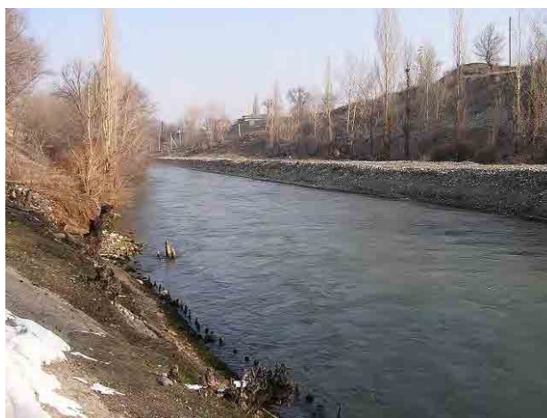
写真 5-7-14 Lebedinovka 発電所の掘込み放水路
