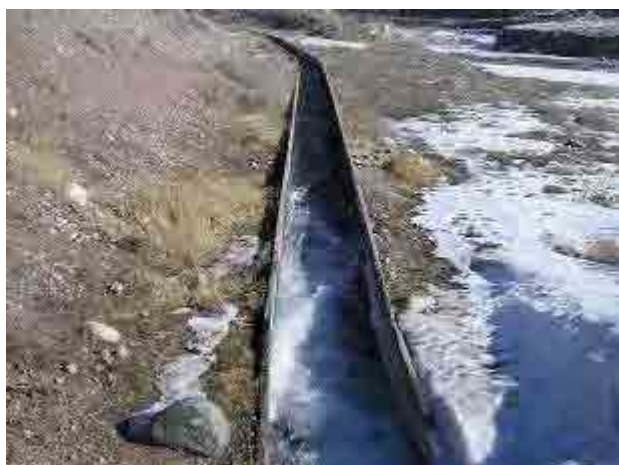
写真 5-7-3 : 取水口付近の導水路
