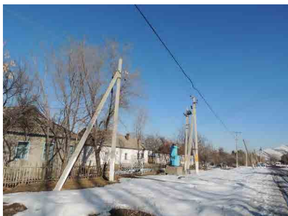
写真 5-4-1 10kV 配電線 (左) と 10/0.4kV 変圧器 (右) (Kegeti 村)
