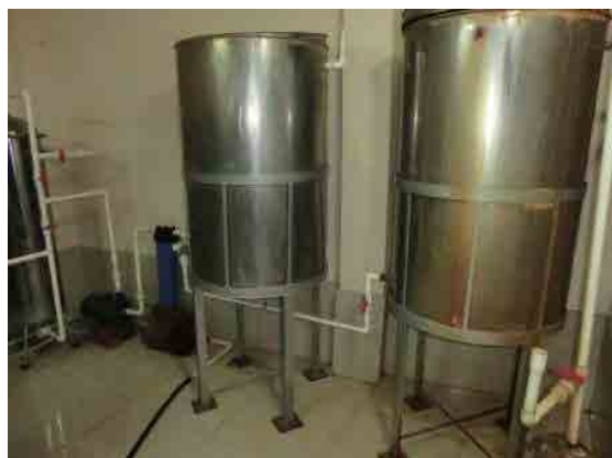
SK Fresh Mineral Water 工場内
