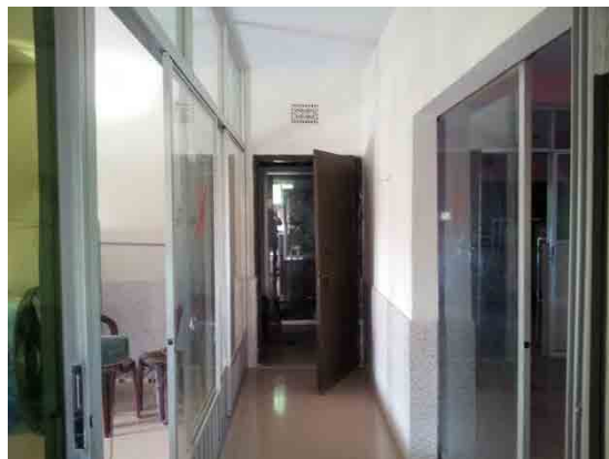
充てん室の仕切り (左側)
