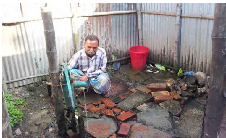
図 3-3 地区内に設置されている給水拠点
