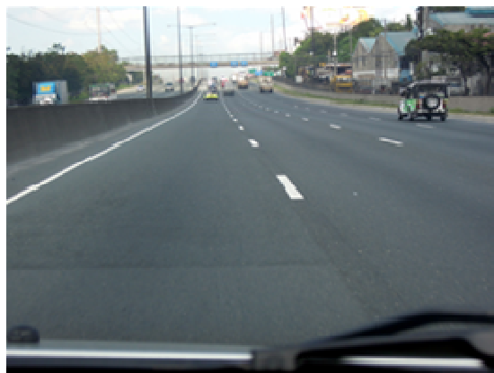
図 19.1-3 マニラノース道路の道路状況
