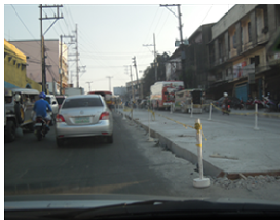
(道路補修工事)
