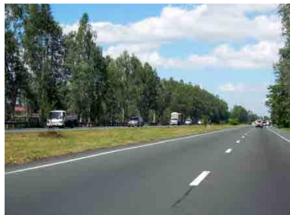
図 19.1-4 北ルソン高速道路の道路状況
